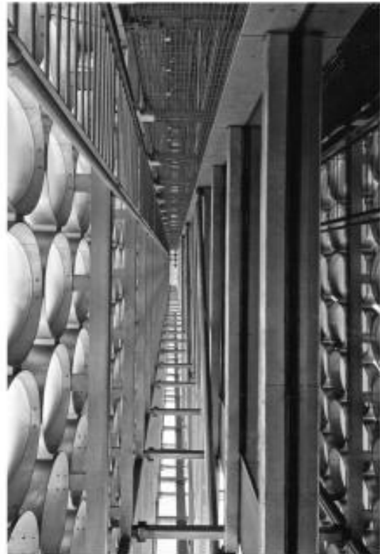
Ilustración 4 RMIT: Sección de la doble fachada. Perspectiva de la cámara de gas argón. Tomado de AAVV. El croquis, Sean Godsell
