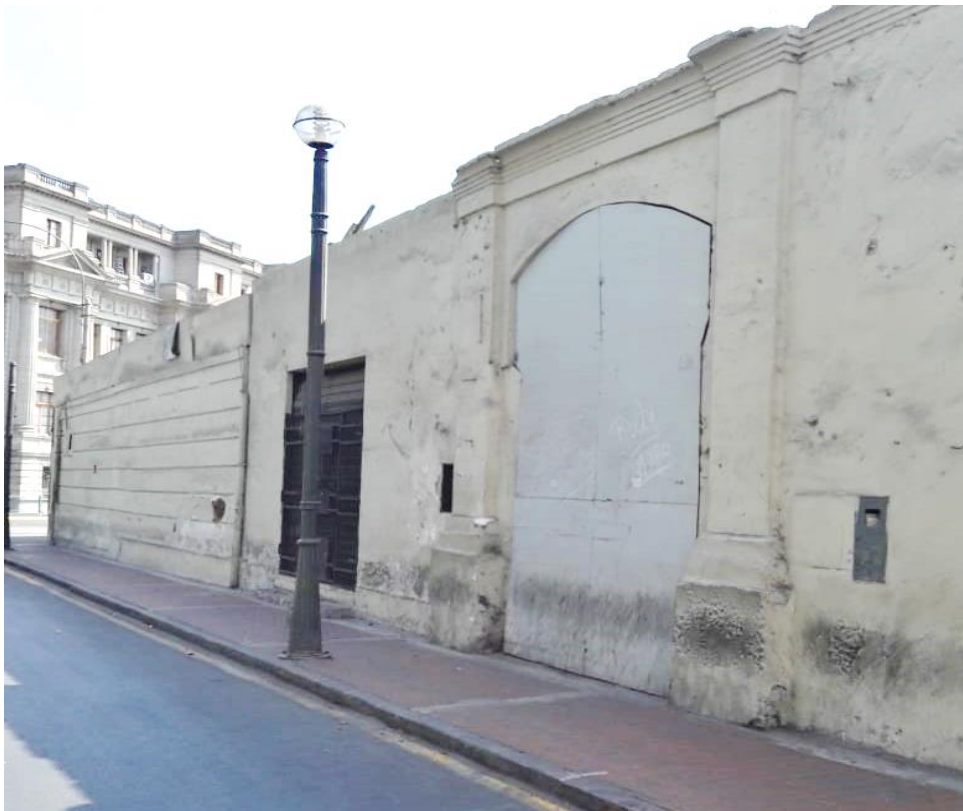
Figura N°59: Fotografía del terreno en Av. Paseo de la Republica. Fuente: Propia.
