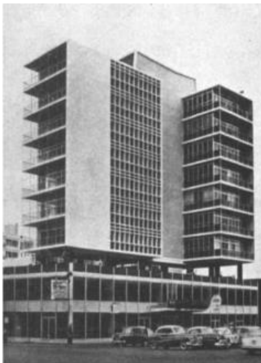
Figura N°4: Edificio El Pacifico, por Fernández, S. 1996. Recuperado del Catálogo de Arquitectura Movimiento Moderno del Perú, Lima, Perú.
