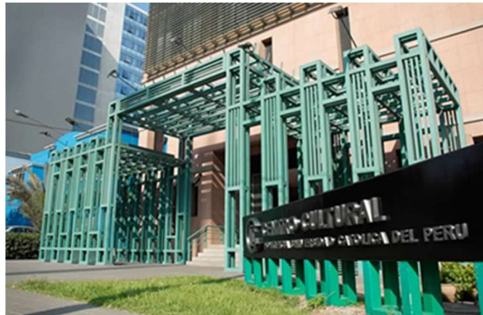
Imagen 6. Entrada principal con estructura metálica en fachada. Fuente. http://www.enlima.pe
