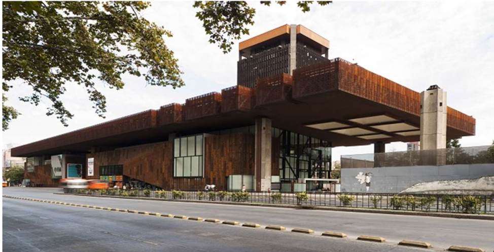
Imagen 2. Vista de la fachada principal del Centro Cultural Gabriela Mistral que muestra su monumentalidad.
