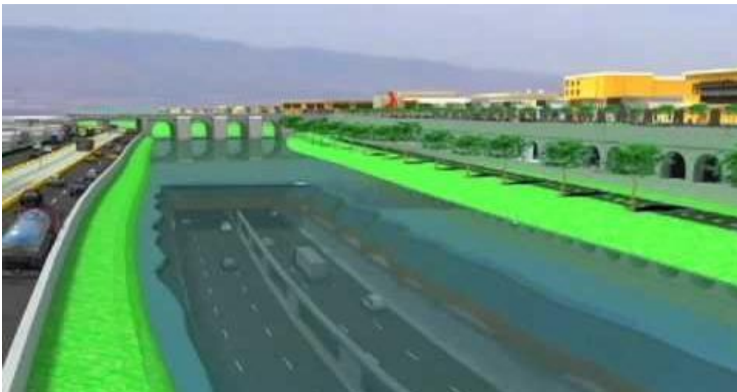
Figura 23: Línea Amarilla – Túnel debajo del Río Rímac y el Puente de Piedra. Fuente: LAMSAC - infografía
