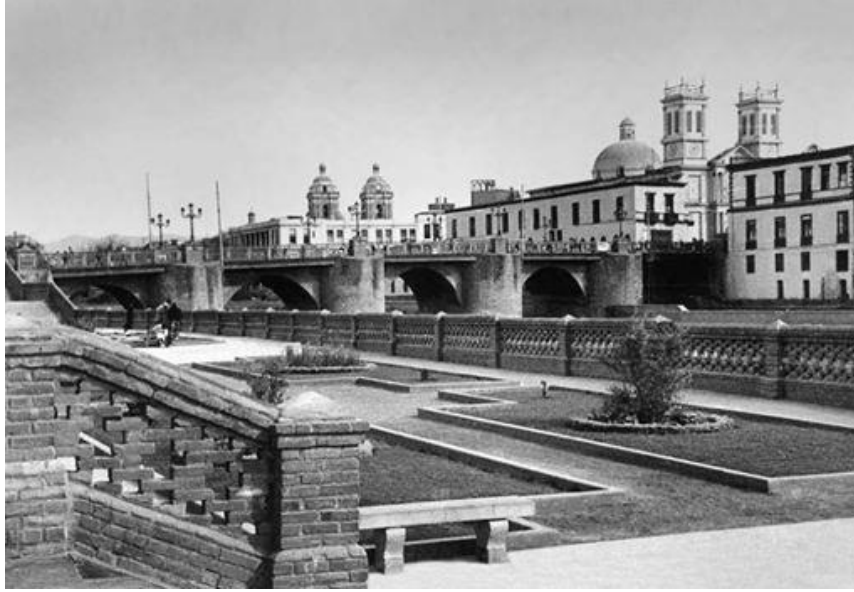
Figura 13: Fotografía Malecón Leguía y el Puente de Piedra. Fuente: Marco Antonio Capristan Núñez.
