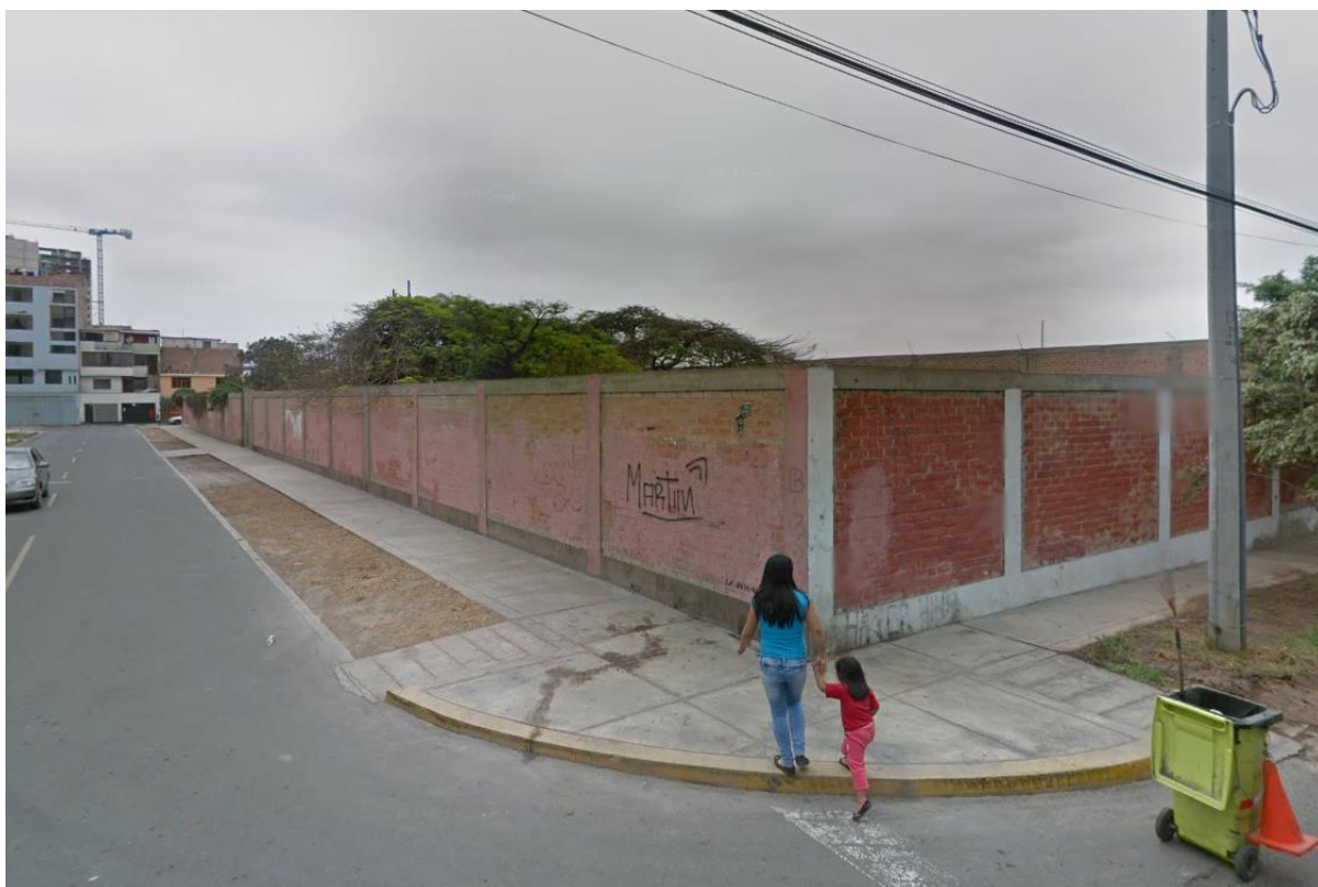
Ilustración 20. Jirón Prolongación Diego Ferré. Santiago de Surco (Google Maps, 2020)
