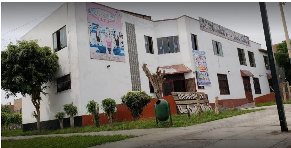
Ilustración 2. . Vista exterior del Centro Comunal Santa María. (Google Maps, 2020)
