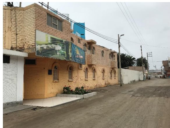
Figura 36: Fachada Hostel Las Palmeras
