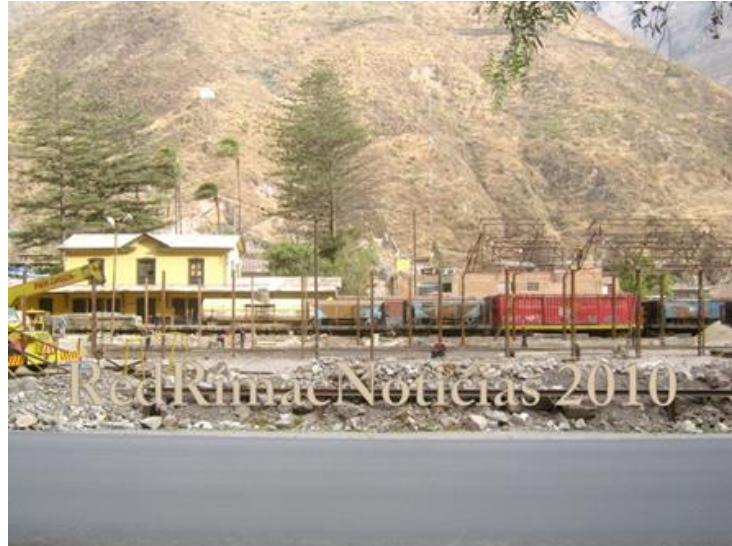
Figura 13. Instalaciones en plena construcción año 2010, a una cuadra de la plaza de Armas de Matucana, su funcionamiento generaría contaminación en la ciudad de Matucana. Fuente: Red Rimac Noticias (2010).
