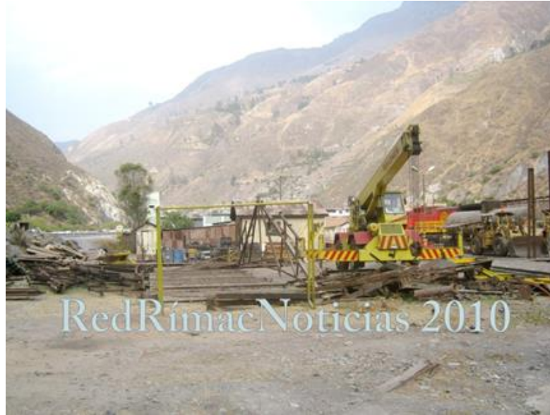
Figura 15. Instalaciones en plena construcción año 2010, a una cuadra de la plaza de Armas de Matucana, su funcionamiento generaría contaminación en la ciudad de Matucana. Fuente: Red Rimac Noticias (2010).
