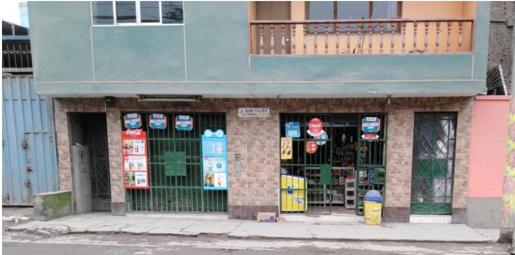
Figura 5. Imágenes del local evaluado – Actualidad. Fuente: Elaboración propia
