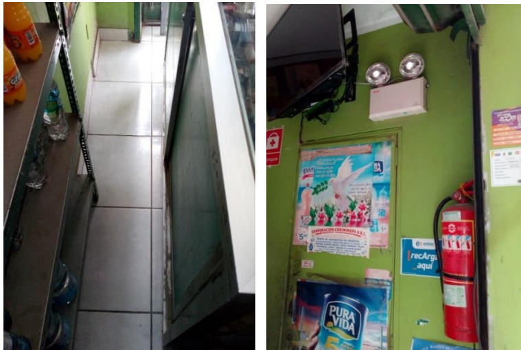
Figura 21. Área de atención – pasillos angostos en zonas de evacuación. Fuente: Elaboración propia
