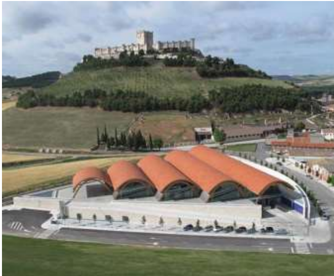
Foto 6. Bodega Protos en España
