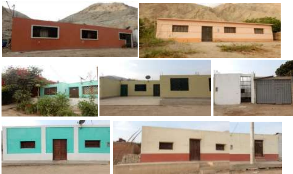
Foto 29. Viviendas de concreto de 1 piso en Lúcumo. Fuente: Elaboración propia.
