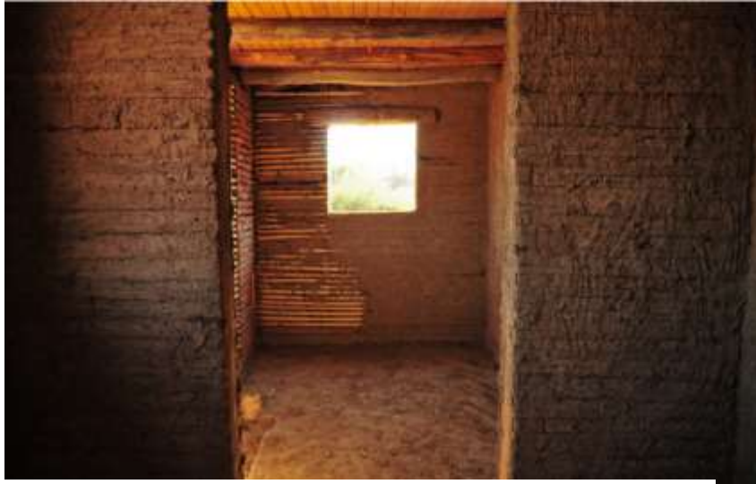
Foto 48. Paredes de quincha revocadas
