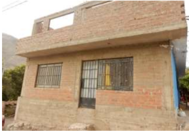
Foto 32. Viviendas de concreto de 2 pisos en Lúcumo. Fuente: Elaboración propia.
