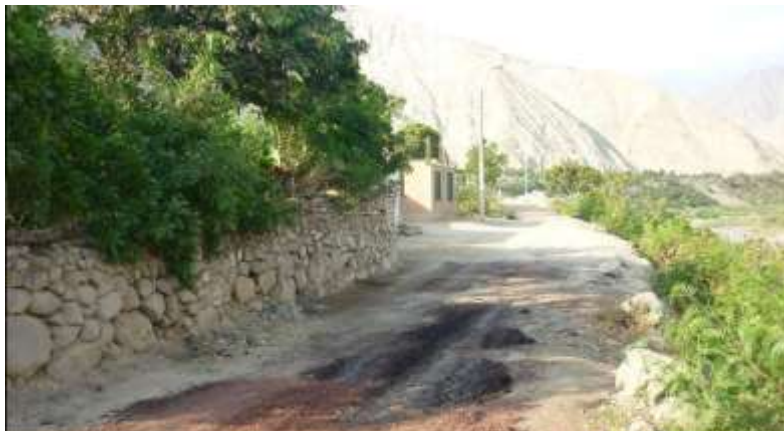
Foto 26. Vista de la carretera Lúcumo Fuente: Facebook Anexo Lúcumo Lunahuaná.
