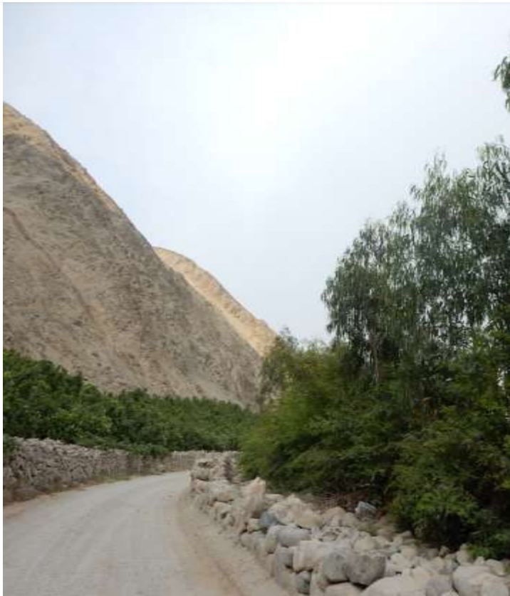
Foto 40. Vista desde la carretera hacia el ingreso del terreno elegido. Fuente: Elaboración propia.
