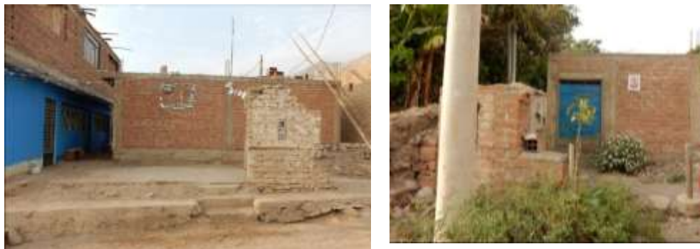
Foto 33. Viviendas de concreto en proceso de construcción. Fuente: Elaboración propia.
