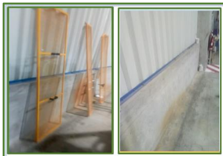
Figura 31. Zona de tránsito despejada Fuente: Datos de la empresa. Elaboración propia
