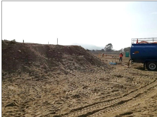
Figura N° 63: Terraplén construido y emisión de agua Fuente: Elaboración propia
