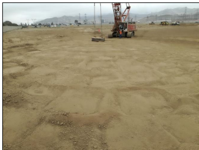
Figura N° 70: Fase de Ironing o “planchado”.
