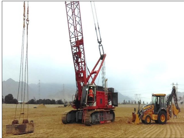
Figura N° 58: Equipos pesados para la ejecución del proyecto. Fuente: Elaboración propia
