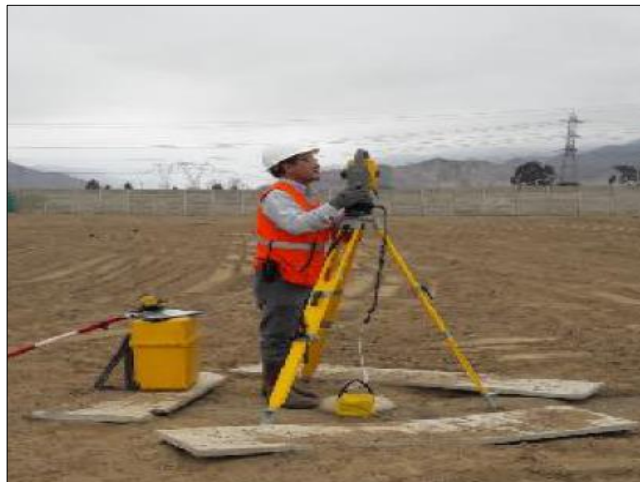
Figura N° 59: Presentación del equipo de estación total. Fuente: Elaboración propia
