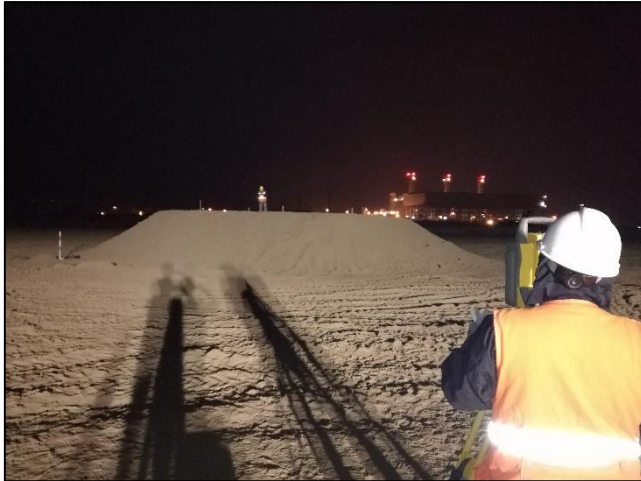
Figura N° 64: Medición del asentamiento del terraplén.
