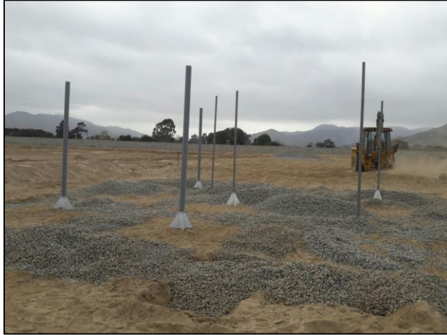
Figura N° 62: Llenado de zanjas con piedra chancada Fuente: Elaboración propia
