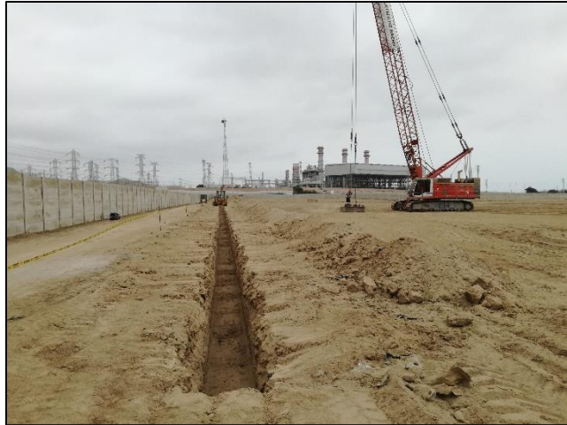
Figura N° 65: Excavación de zanja para prueba de vibración. Fuente: Elaboración propia.
