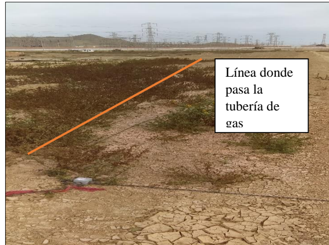
Figura N° 52: Ubicación de geófono en posición paralela al eje de la línea de gas.
