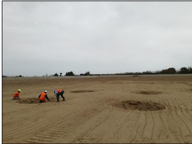
Figura N° 69: Medición de huellas post Fase 1.
