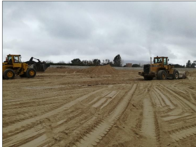
Figura N° 51: Nivelación del terreno previo a trabajos de compactación Fuente: Elaboración propia
