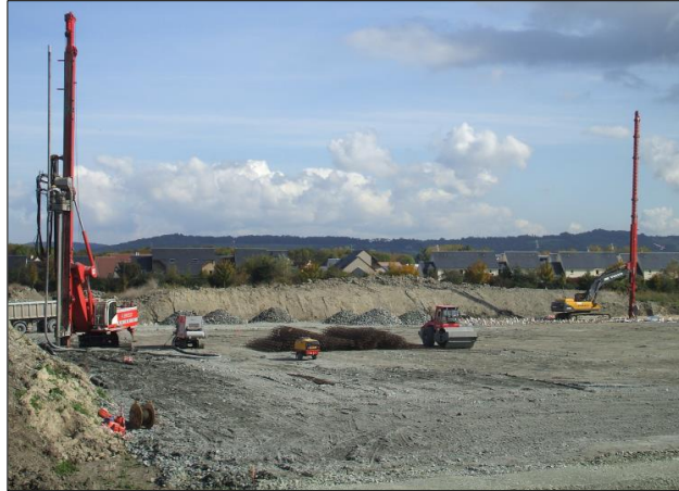
Figura N° 42: Línea Ferroviaria Tangentielle Légère Nord - Francia. Fuente: Elaboración propia
