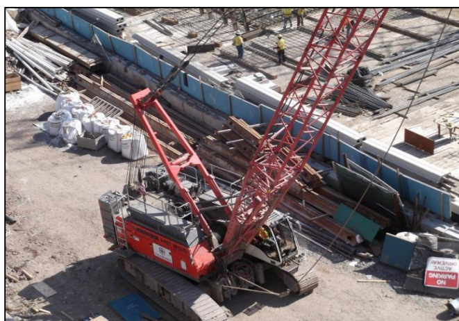
Figura N° 26: Grúa de celosía marca Liebherr Modelo HS855
