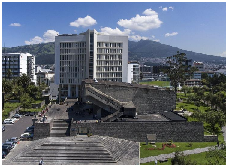
Imagen 3. Vista exterior del TEATRO DE LA ESCUELA POLITÉCNICA NACIONAL . Fuente sitio web:
