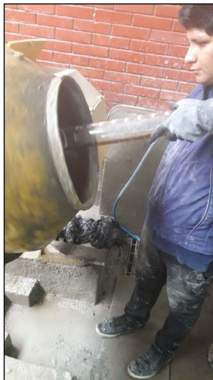
Figura 31: Preparado de materiales en mezcladora Fuente: Elaboración Propia
