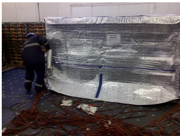
Figura 46. Armado con manta térmica Fuente: Elaboración propia
