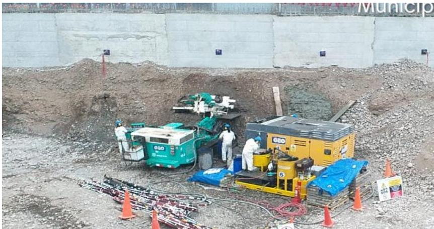
*Figura 8.* Perforación de muros anclados
