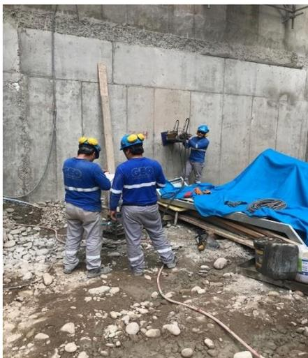
*Figura 10.* Tensado de anclaje en obra Altovento
