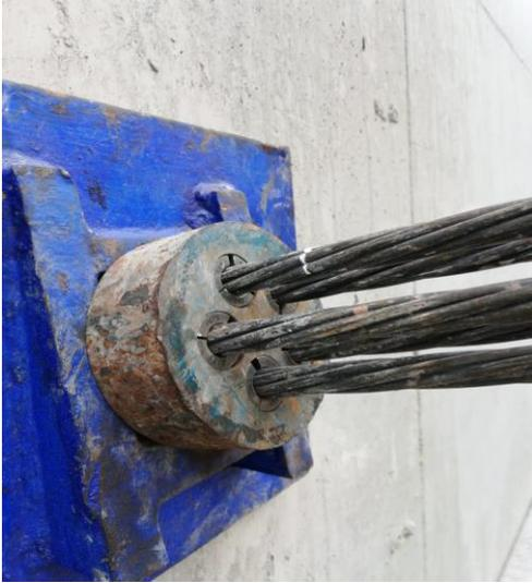
*Figura 43.* Anclaje con tensado hasta carga de bloqueo
