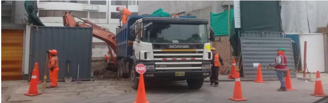
*Figura 7.* Eliminación de tierra en obra Océano Atlántico – EF-CONSTRUCTORES
