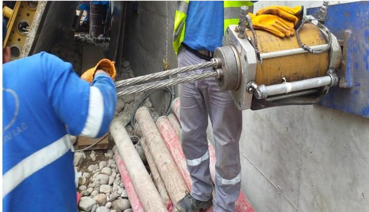
Figura 40. Instalación de los platos, el gato hidráulico y cuñas de arrastre
