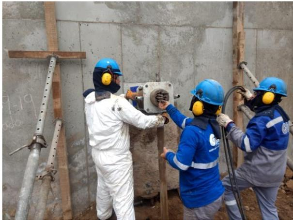
*Figura 37.* Muro apuntalado para el ensayo de capacidad
