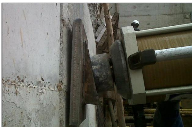
Figura 39. Instalación de la platina y cabezal
