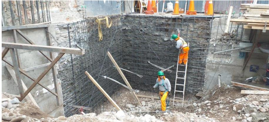
*Figura 9.* Construcción de muros anclados – obra Marsano
