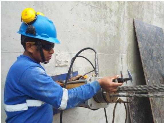
*Figura 35.* Medición de la deformación con Vernier
