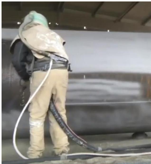
Figura 45. Patrón de aplicado del arenado
