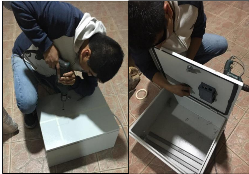
Figura N°60: Instalación de componentes en puerta de tablero Fuente: Elaboración propia
