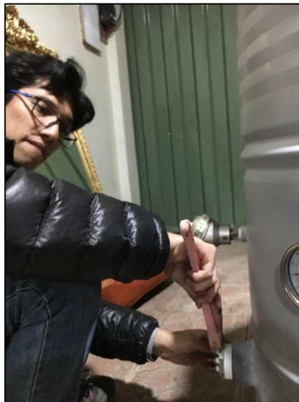
Figura N°52: Instalación mecánica de elemento calefactor Fuente: Elaboración propia
