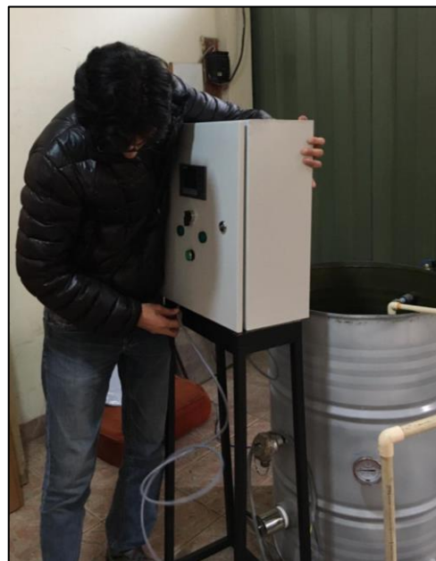
Figura N°61: Instalación de tablero Fuente: Elaboración propia
