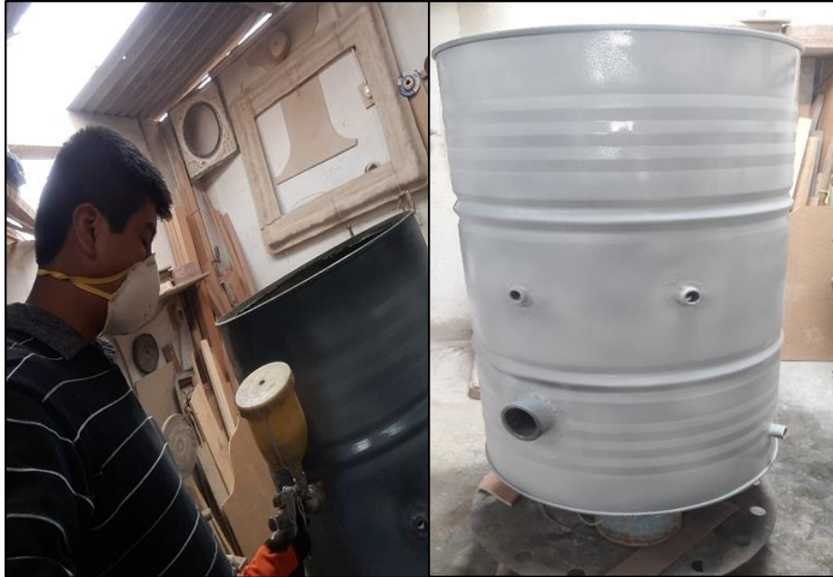
Figura N°51: Pintado de tanque - calentador Fuente: Elaboración propia
