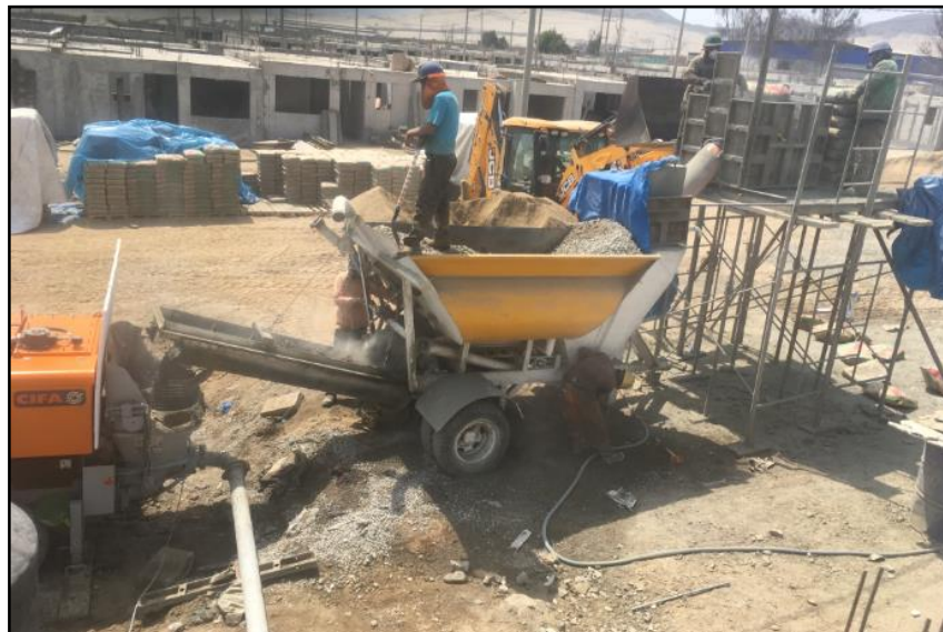
Figura 44: Implementación del alimentador de cemento.
