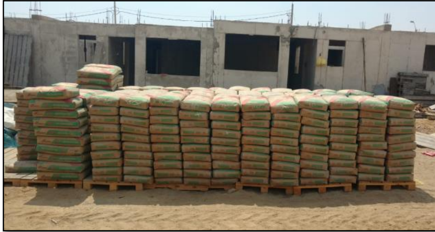
Figura 35: Almacenaje de bolsas de cemento en área de trabajo.
