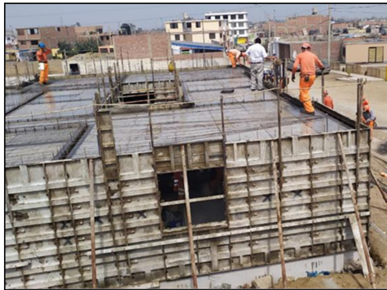
Figura 14: Encofrado para sistema monolítico
