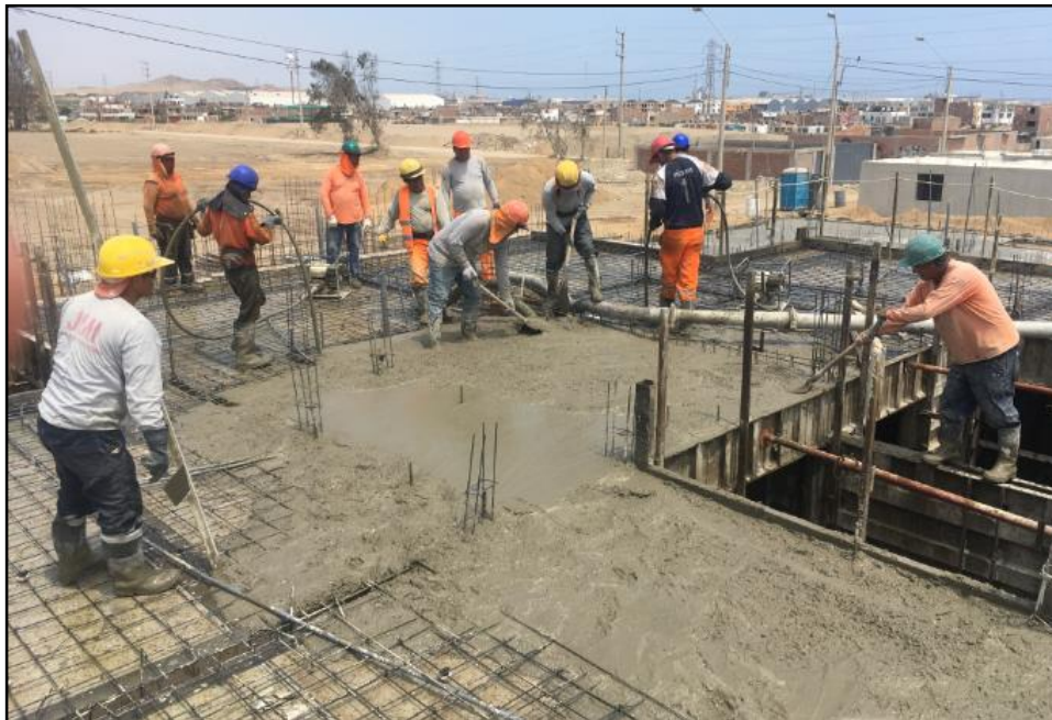
Figura 38: Cuadrilla en pleno trabajo de vaciado de concreto en losa.
