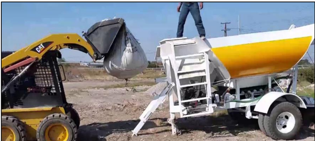
Figura 25: Abastecimiento de agregados
