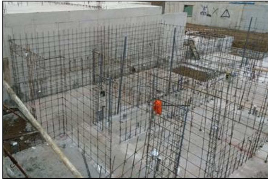
Figura 13: Refuerzo de muros de ductilidad limitada
