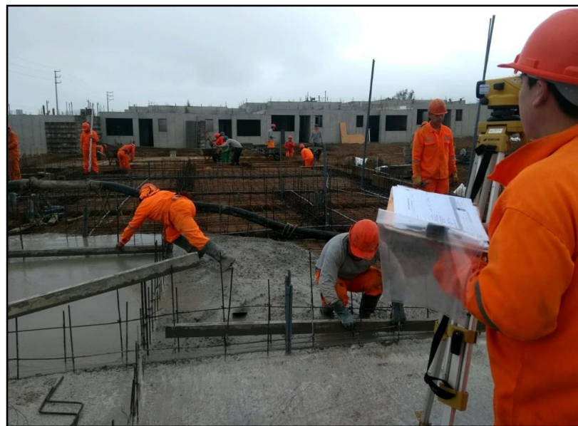
Figura 12: Vaciado de concreto de platea
