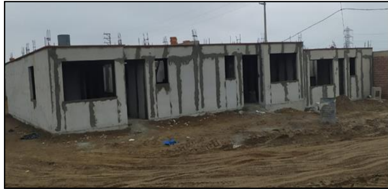
Figura 15: Desencofrado luego de 24 horas del vaciado
