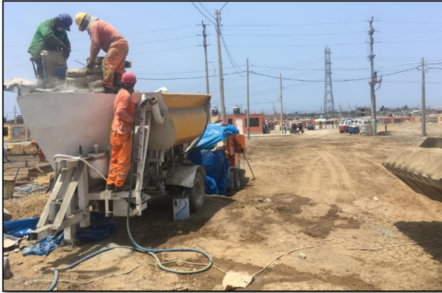
Figura 43: Abastecimiento de cemento en la planta dosificadora.
