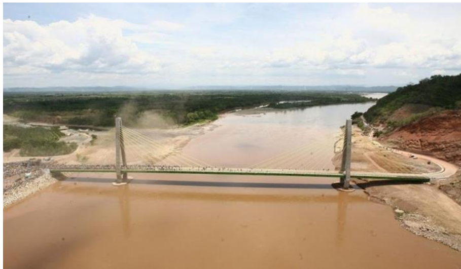
Figura 10 Vista de puente Bellavista
