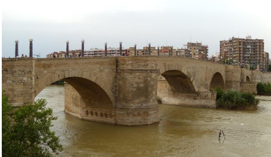
Figura 2 Vista de puente de mampostería o piedra
