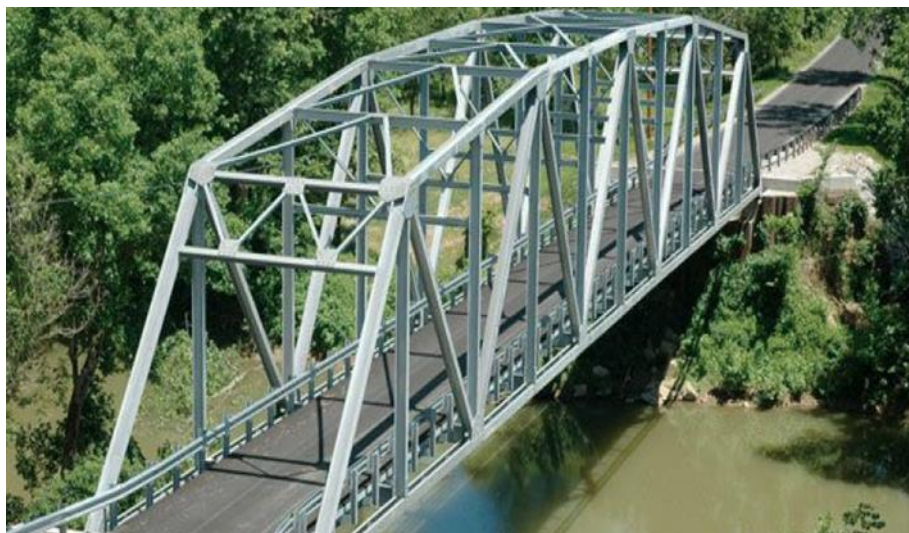
Figura 3 Vista de puente de acero
