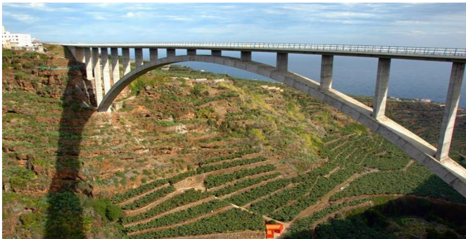
Figura 6 Vista de puente en arco
