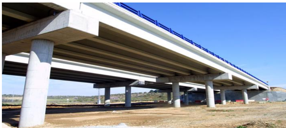
Figura 5 Vista de puente de vigas
