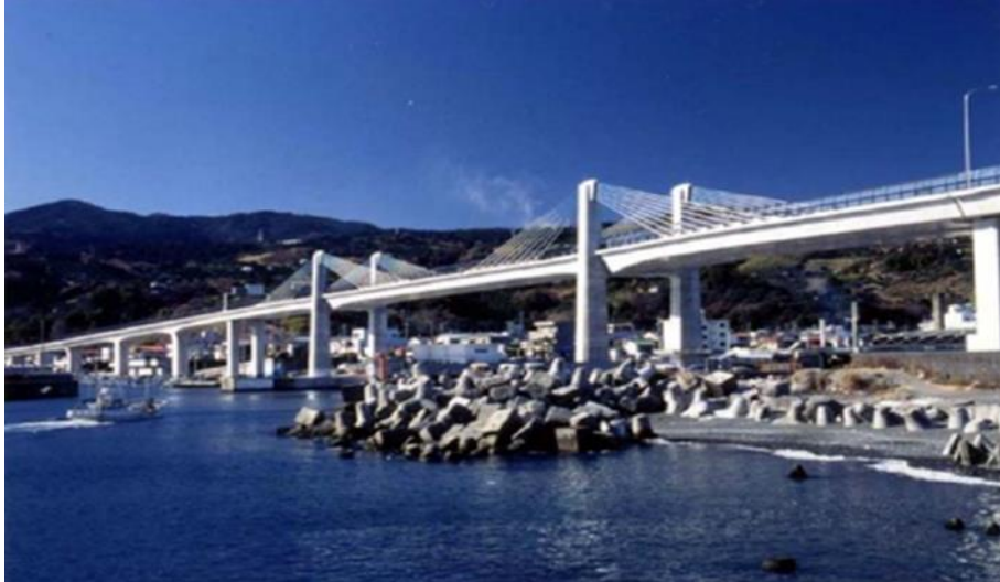
Figura 12 Vista puente Odawara Blueway
