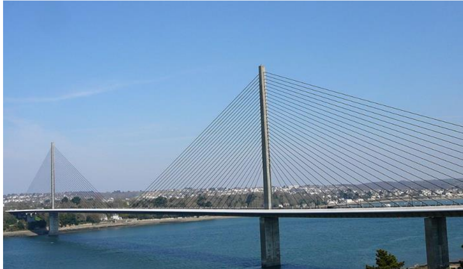
Figura 8 Vista del puente del Iroise
