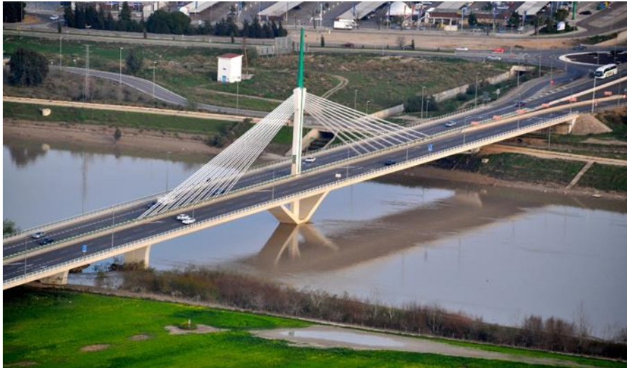
Figura 14 Vista Puente Andalucía
