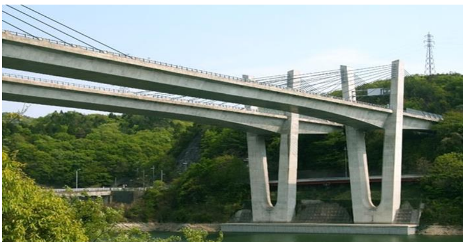
Figura 13 Vista puente Tsukahara
