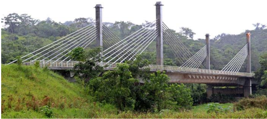
Figura 11 Puente de la Integración de Acre
