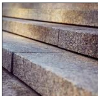
Figuras 148. Granito rojo en escaleras de ingreso. Fuente: Pinterest.
