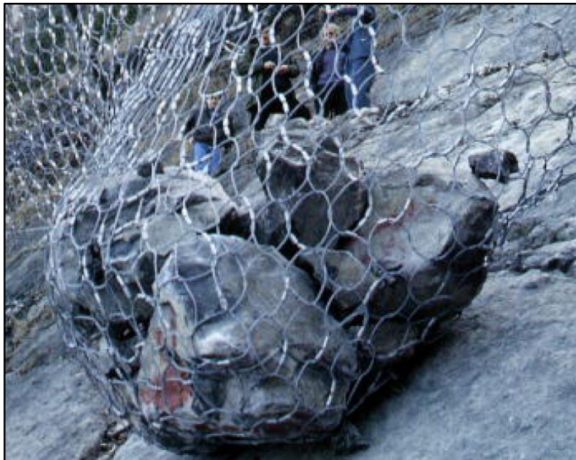
Figura 20. Retención de rocas a través de una barrera dinámica.
