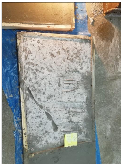
Figura 21 Tratamiento de calor y aire, no se presentaron fisuras
