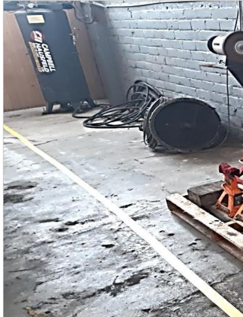
Figura 59. Ordenar – Zona de compresor (antes) Fuente: Elaboración propia
