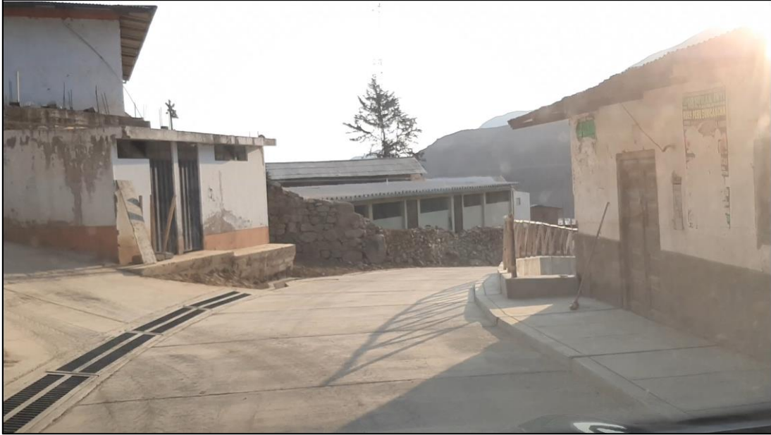
Foto N° 13: Pavimento rígido encontrada la Ruta N° 02 entrando al distrito de Arahua.
