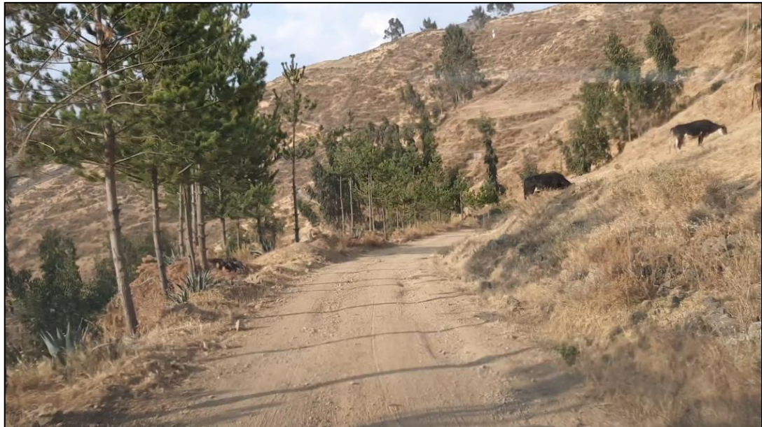
Foto N° 08: Tramo N° 02 en desarrollo del camino de la Ruta N° 02
