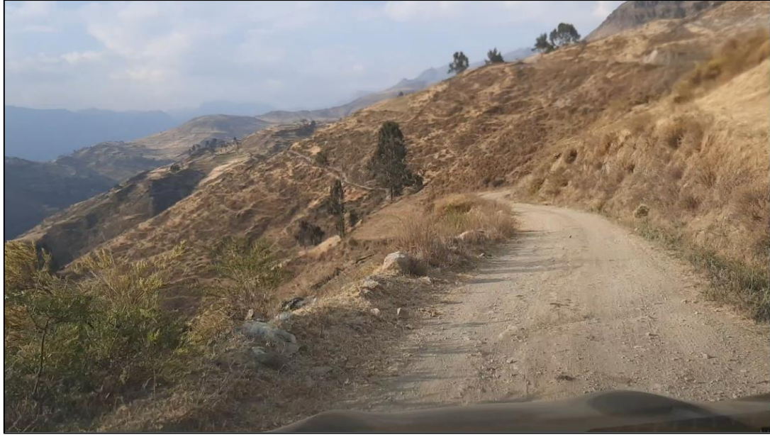
Foto N° 07: Tramo N° 01 en desarrollo del camino de la Ruta N° 02
