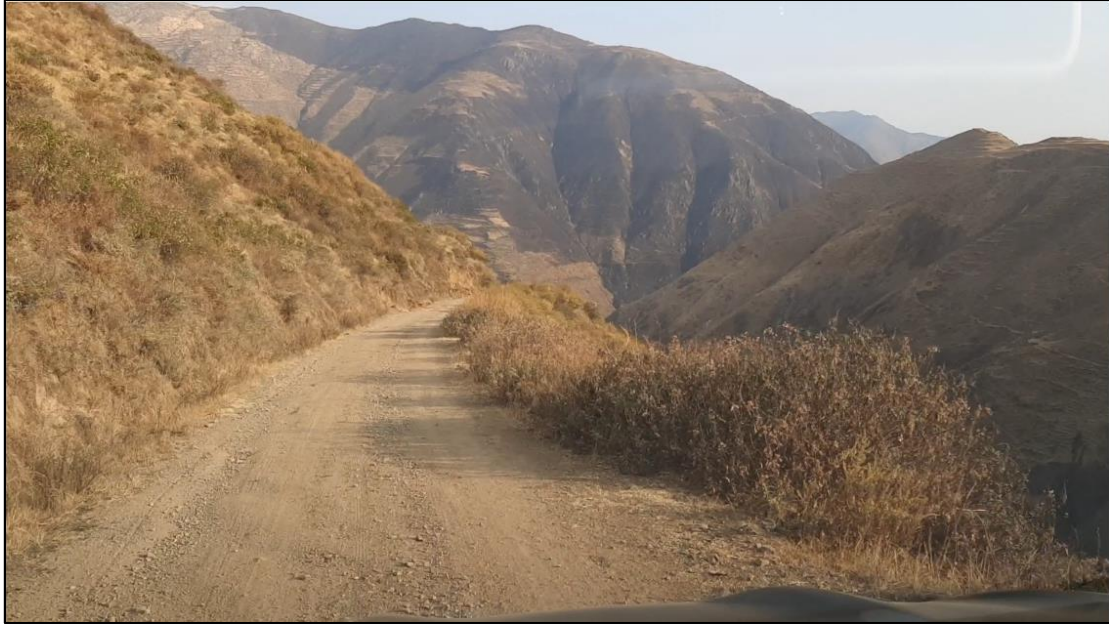
Foto N° 15: Tramos N° 01 de descanso para el vehículo de la Ruta N° 02.
