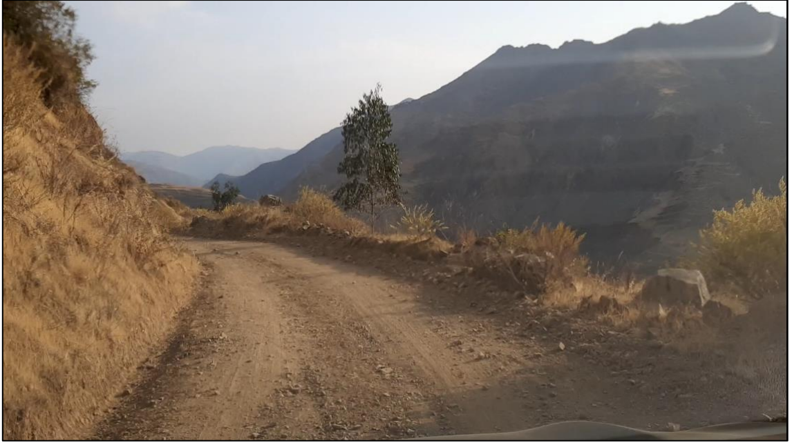
Foto N° 09: Tramo N° 03 en desarrollo del camino de la Ruta N° 02
