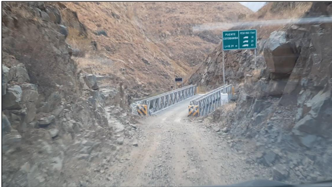
Foto N° 12: Puente Cotobamba de la Ruta N° 02.
