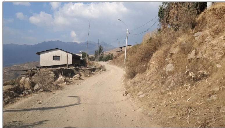
Figura N° 60: Fotografía en la pendiente Máxima y Mínima de la Ruta N°1
