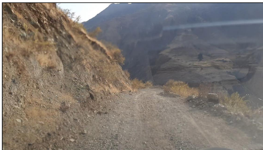
Figura N° 62: Fotografía en la Pendiente Máxima de la Ruta N° 2
