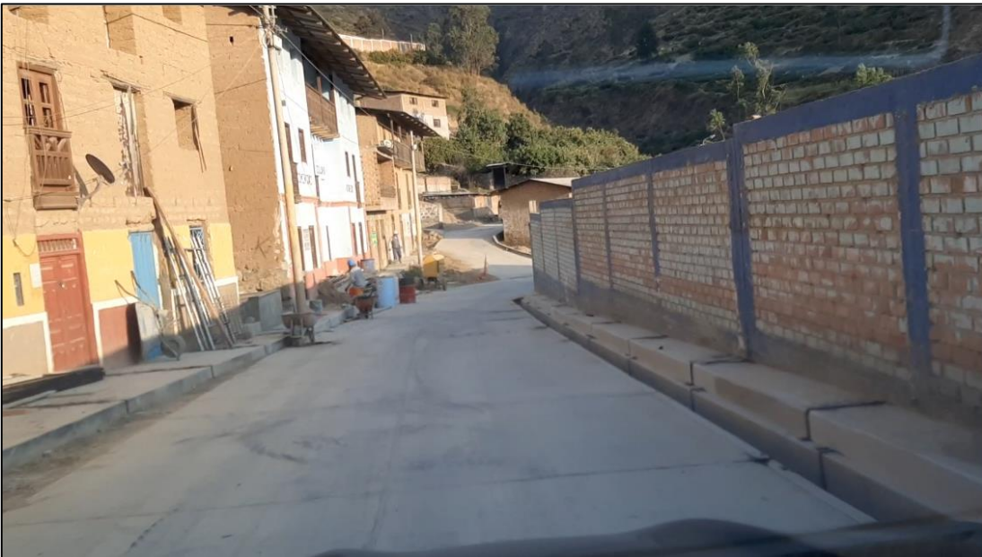
Foto N° 14: Pavimento rígido encontrada de la Ruta N° 02 saliendo del distrito de Arahua.
