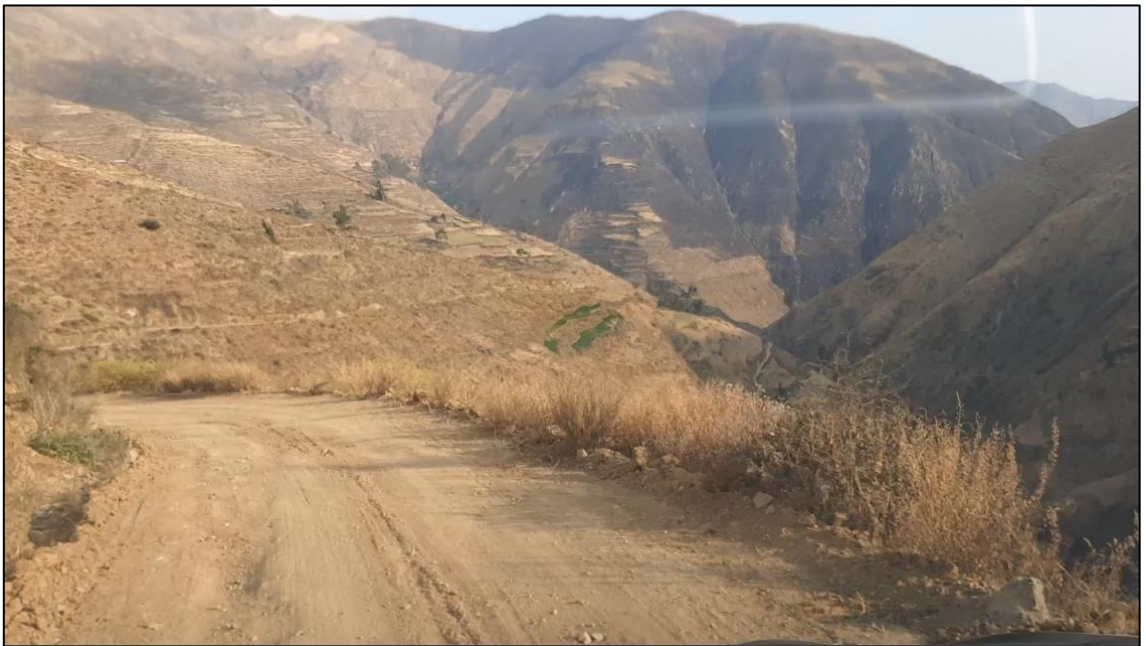
Foto N° 10: Tramo N° 04 en desarrollo del camino de la Ruta N° 02
