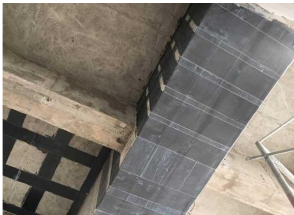
Figura N° 1: Reforzamiento con fibras de carbono
