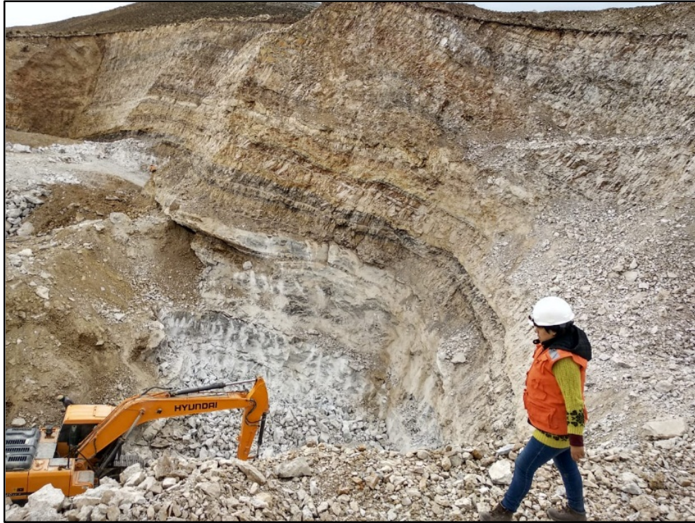
Figura 30: Extracción de la materia prima con el martillo hidráulico
