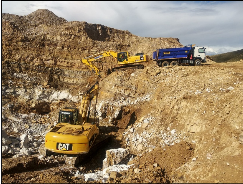
Figura 46: Continuación del corte de talud según resultados del diseño del tajo
