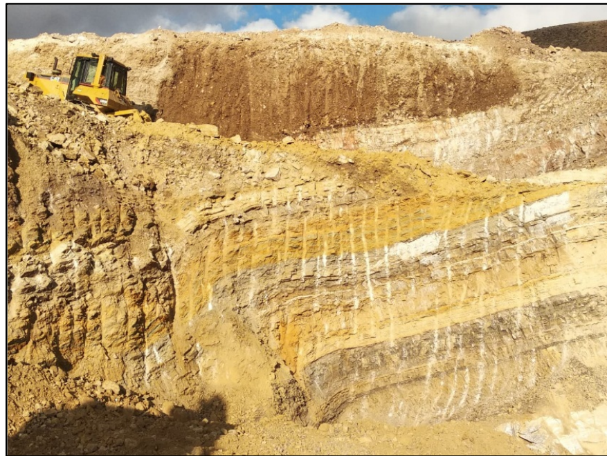
Figura 45: Inicio del corte de talud según el diseño
