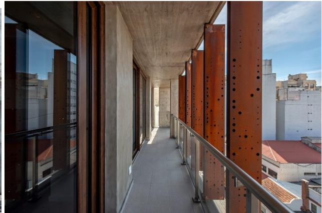
Foto 4: Acabados de la fachada. Vecchi, S. (2018). Recuperado de: https://www.archdaily.pe/pe/904707/residencia-estudiantil-z-plus-bcg-
