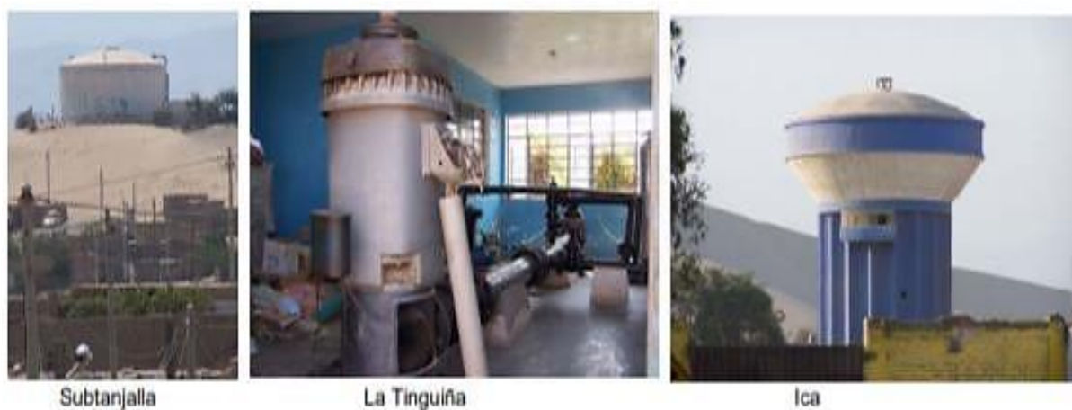
GRÁFICO 30: Reservorios de agua en Ica Fuente: INDECI
