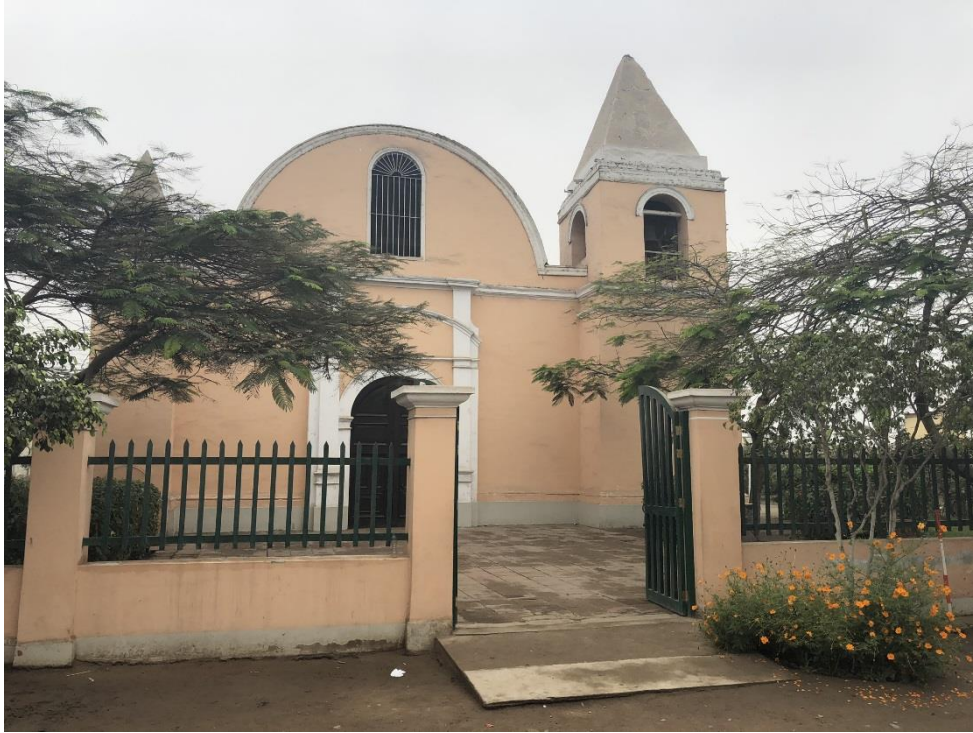
Ilustración 35: Vista 15: vista de Iglesia de San Pedro de Carabayllo, la primera de Lima norte.
