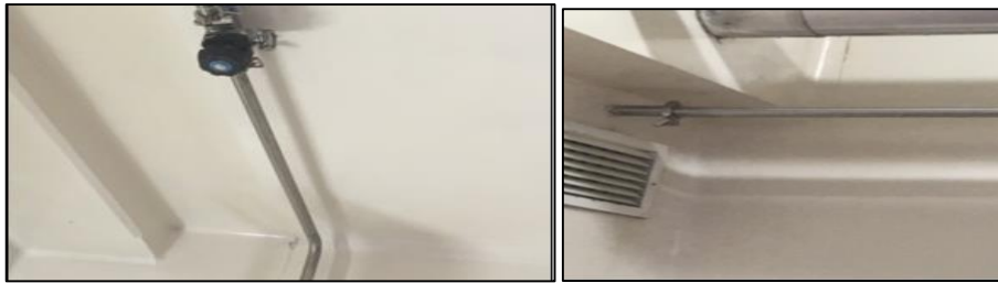
Figura 35: Sistema de trasvase en el Pre-test Fuente: Elaboración propia
