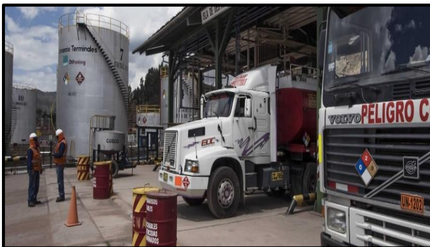
Figura N° 13 Proceso de Despacho de Combustibles
