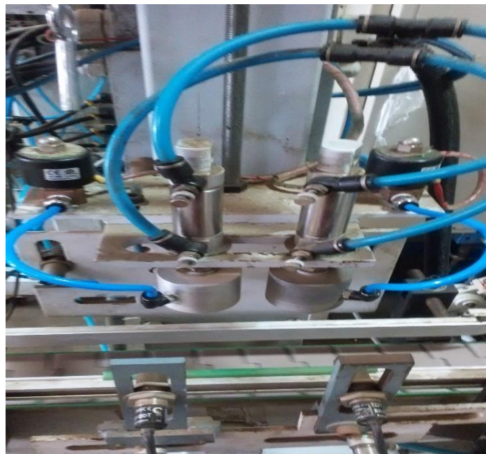
Figura 55. Instalación de la etapa de soplado de la estación 1
