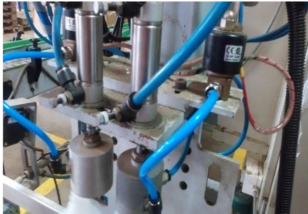
Figura 56. Instalación de la etapa de soplado de la estación 2
