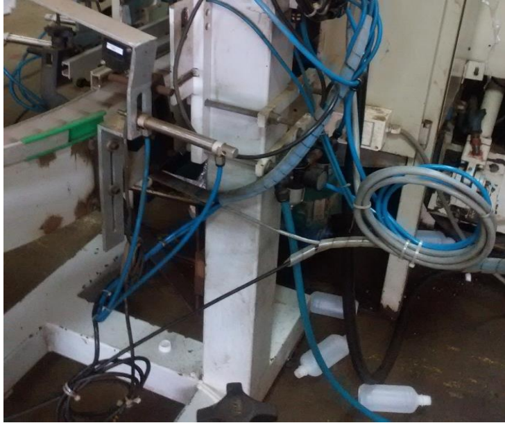
Figura 52. Base de la estructura de la estación 2
