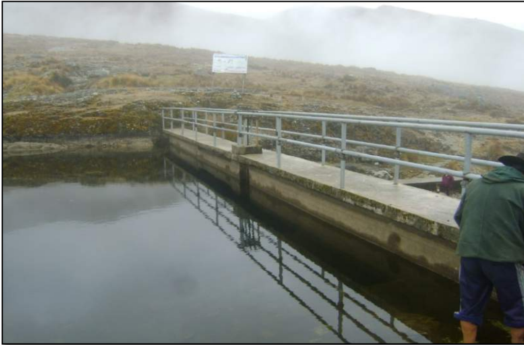
Figura 6: Presa existente de 3 m de altura, contención de la laguna Rontoccocha.
