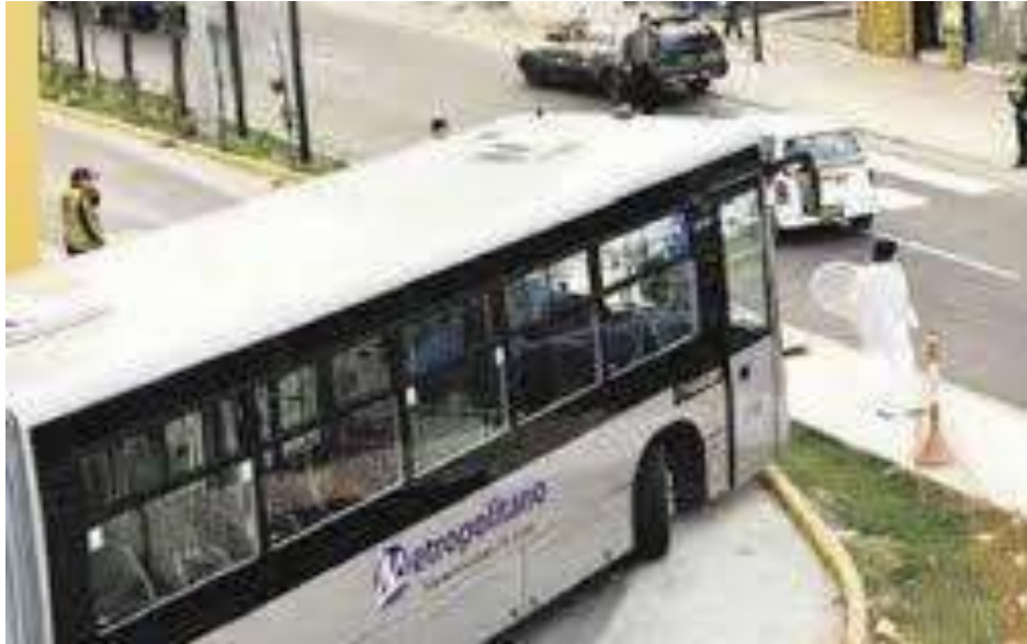
Ilustración 123. Mal diseño del tramo que recorre el Metropolitano
