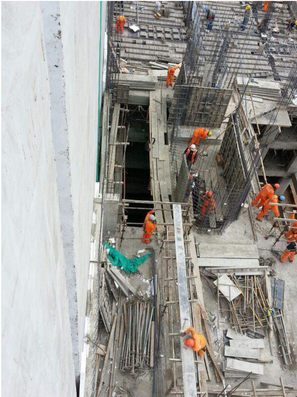
Foto 5: Trabajos programados de encofrado en Sector 2, de techo 3.
