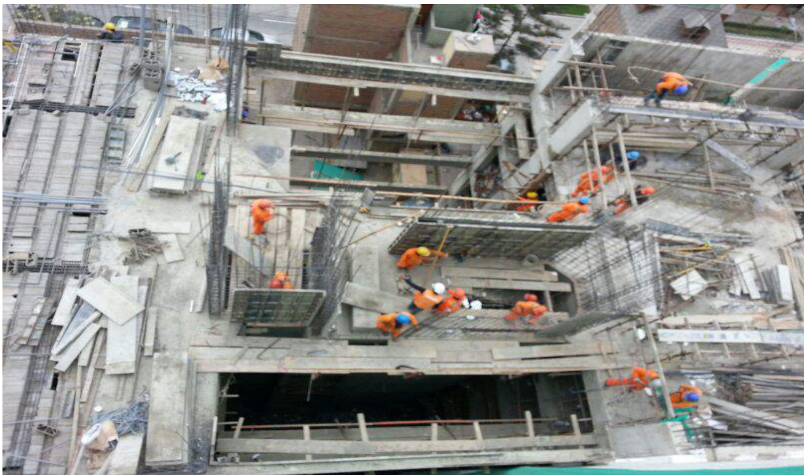
Foto 1: Trabajo de Encofrado de verticales en Sector 2
