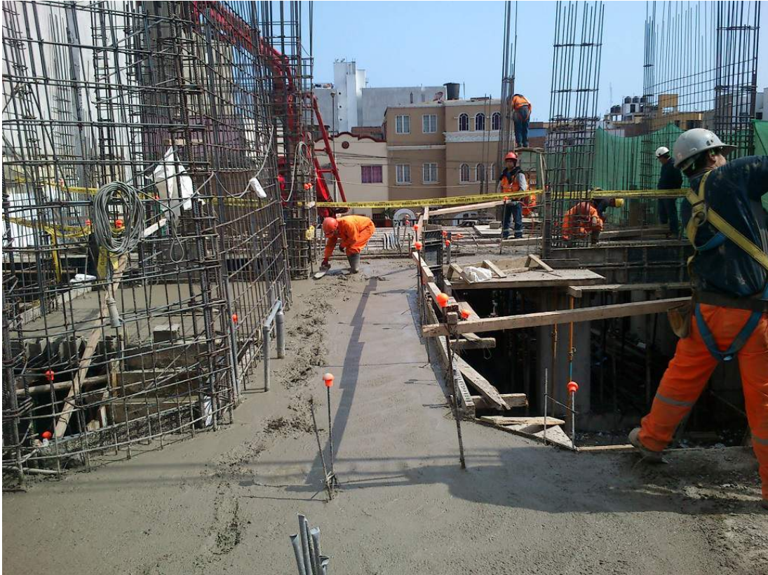
Foto 4: Vaciado de losa maciza en sector 2.
