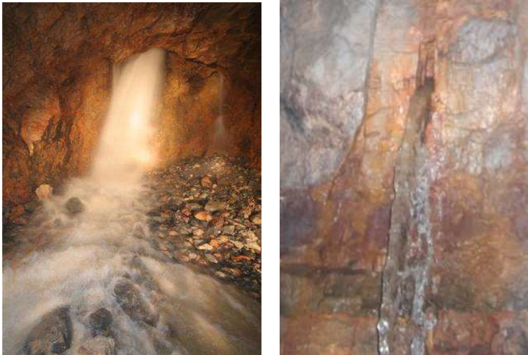
Figura 1.2 - Mecanismos de infiltración desarrollados: Infiltración estacional (alta precipitación), “flujo en conducto” (en cársticos interconectados) e Infiltración a través de fracturas y permeabilidad del macizo rocoso.
