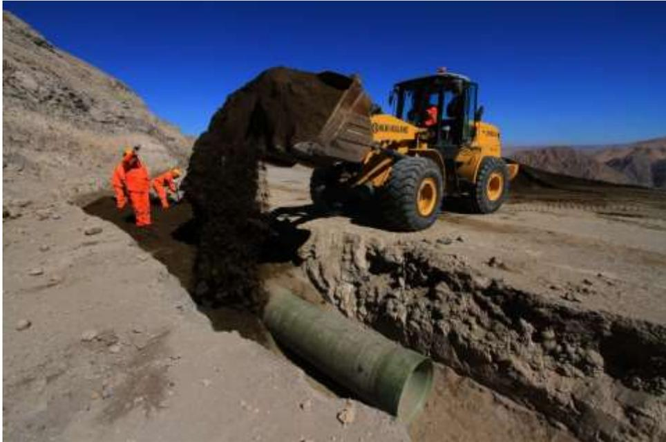
Fotografía 01. Relleno de caja de tubería
