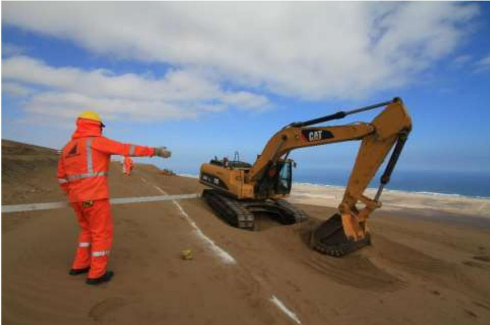
Fotografía 05. Excavación de zanja de tubería
