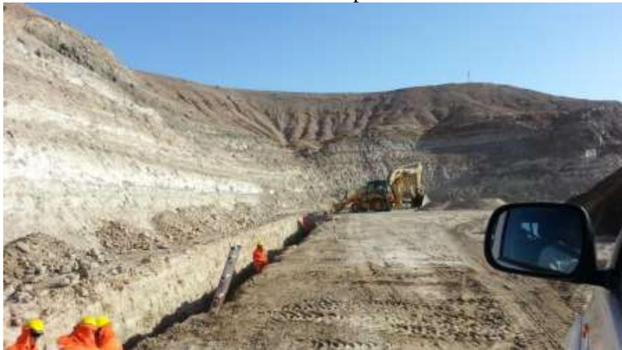
Imagen 4. Excavación de zanja para colocación de tubería
