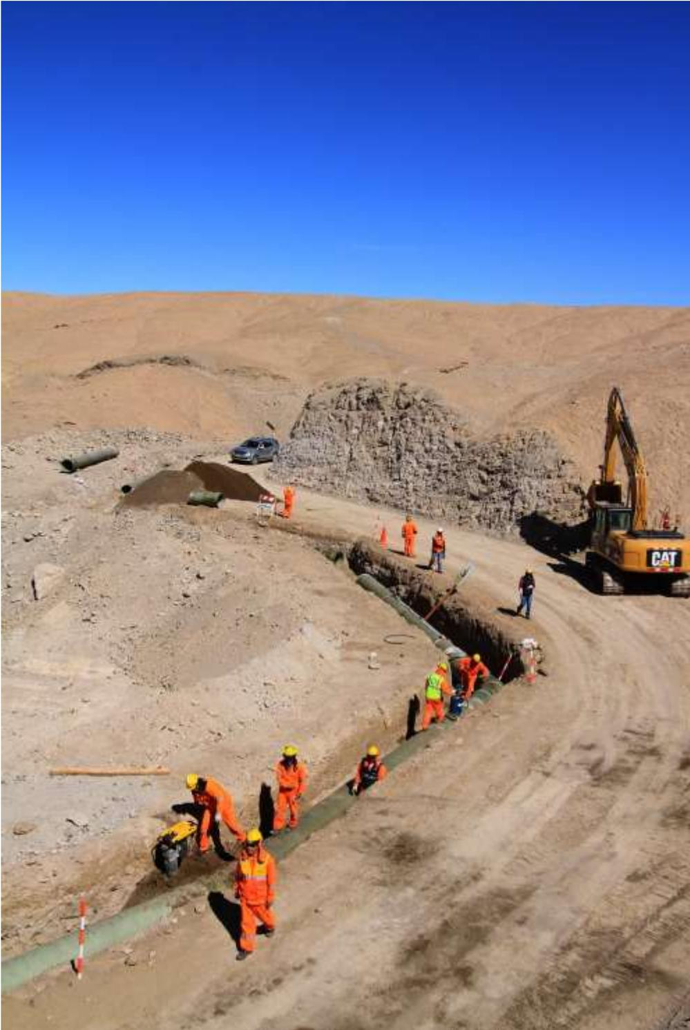
Fotografía 07. Montaje de tubería
