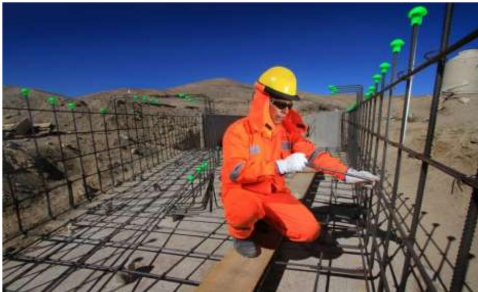
Fotografía 02. Habilitación de acero para el desarenador
