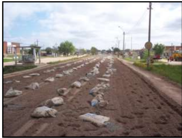
Figura 4-5: Distribución de las bolsas de cemento.
