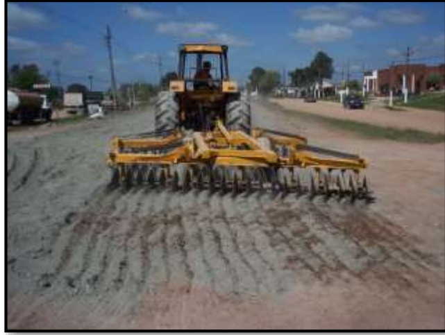
Figura 4-6: Mezcla del suelo cemento en campo.
