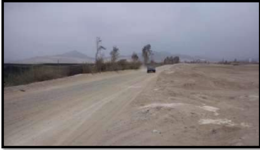
Figura 3-6: Alrededores de la urbanización las Praderas de Lurín
