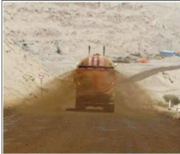
Figura 6-2: Aplicación de la dosis de biopolímero
