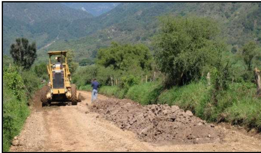
Figura 4-1: Escarificación o pulverización del camino.
