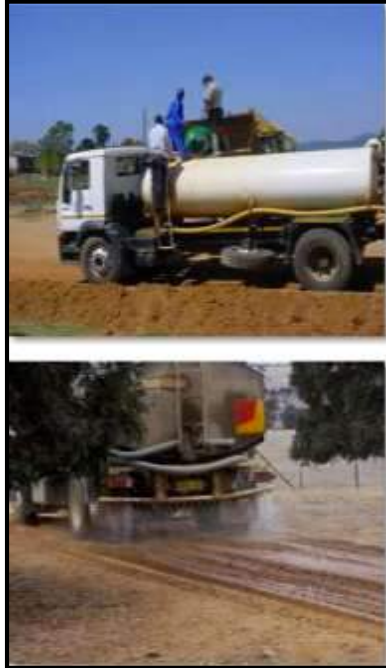
Figura 2-4: Método de aplicación del biopolímero en campo.
