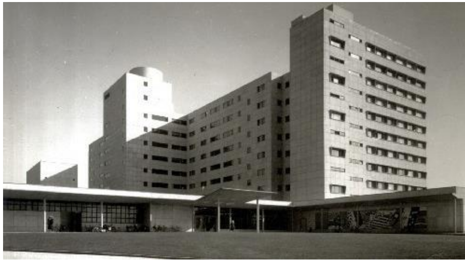
Figura 34 Vista del Hospital Saint Lo, Francia, 1955.
