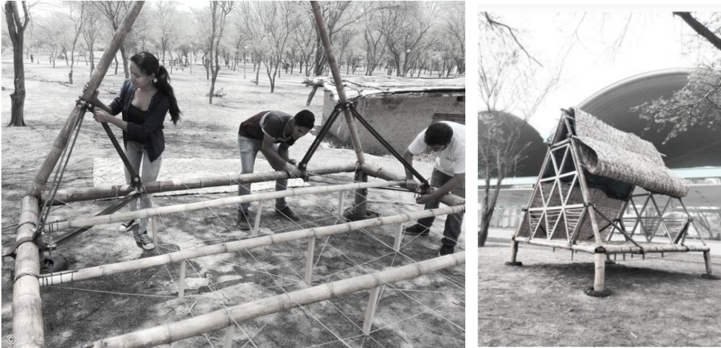
Figura 13: Imágenes de construcción y diseño del refugio Piura
