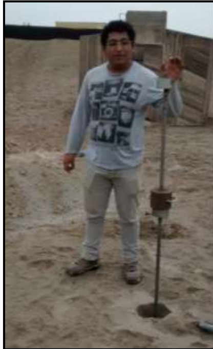
Figura 23. Vista del equipo DPL instalado en el primer punto de exploración, listo para comenzar con el ensayo.
