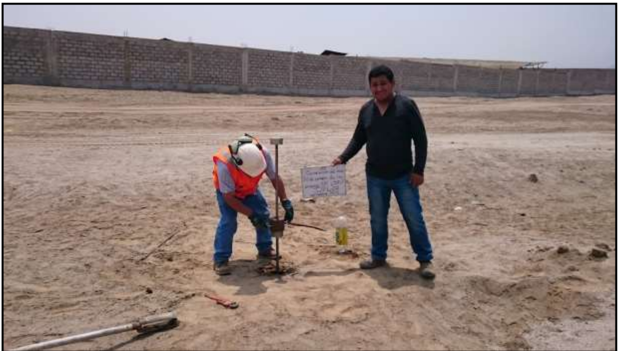
Figura 27. Vista del ensayo DPL - 02, ubicado en la zona nor-este del terreno en estudio; en la imagen se puede observar al personal, debidamente protegido, realizando los ensayos de penetración dinámica.
