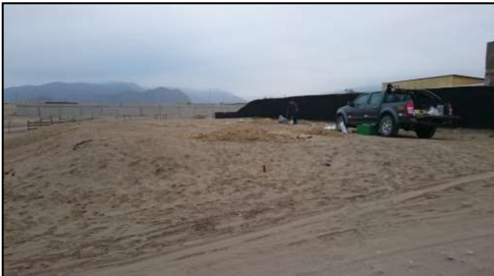
Figura 49. Vista de la ubicación de la calicata C-03.
