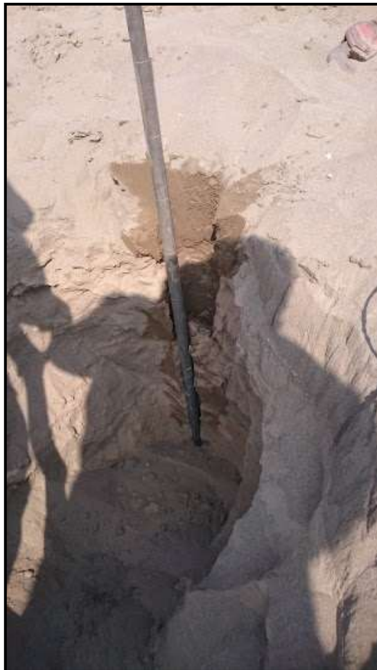
Figura 33. Vista del ensayo DPL - 05, en la imagen se puede observar el equipo DPL, en el cual se debieron ensamblar 02 varillas, ya que la profundidad de penetración fue de aproximadamente 1.80m.
