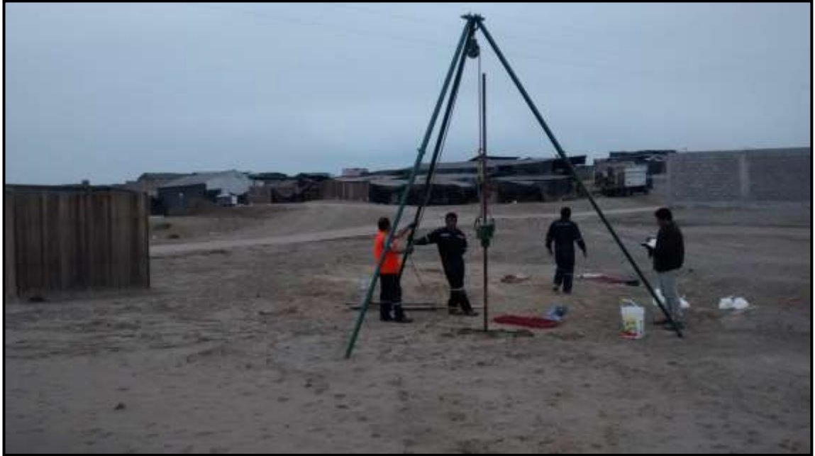
Figura 12. Vista de los trabajos de evaluación de la resistencia del suelo con la profundidad con equipo SPT, en la vista se observa el martillo de 140 Lb, que cae de una altura de 76cm. Donde se mide el número de golpes por cada 15 cm, de penetración.
