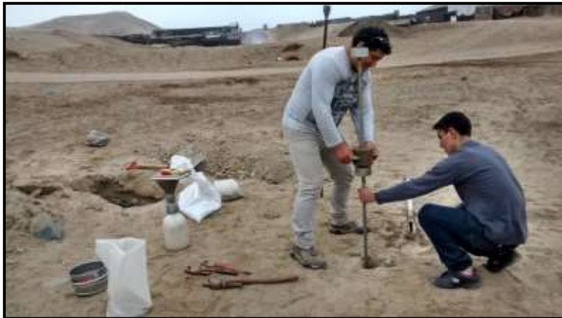
Figura 11. Vista del ensayo DPL realizado en la zona de estudio.
