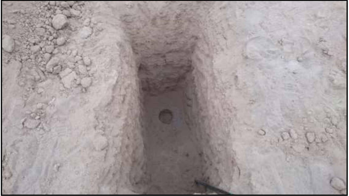
Figura 53. Vista del perfil estratigráfico de la calicata C-04, se observa que los dos estratos encontrados, son bastante similares, también se puede distinguir el pequeño orificio que quedó como consecuencia de realizar el ensayo de cono y arena para calcular la densidad natural.
