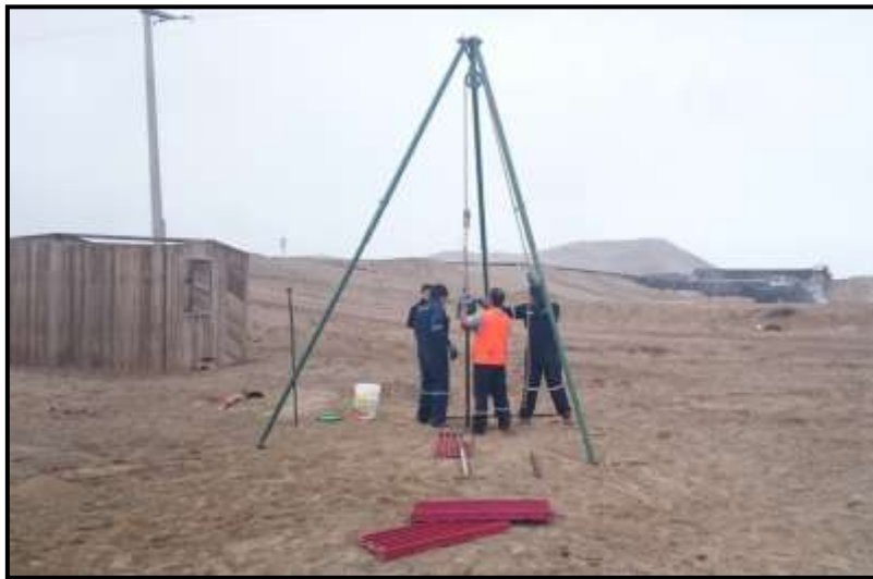
Figura 10. Vista del ensayo SPT realizado en la zona de estudio.
