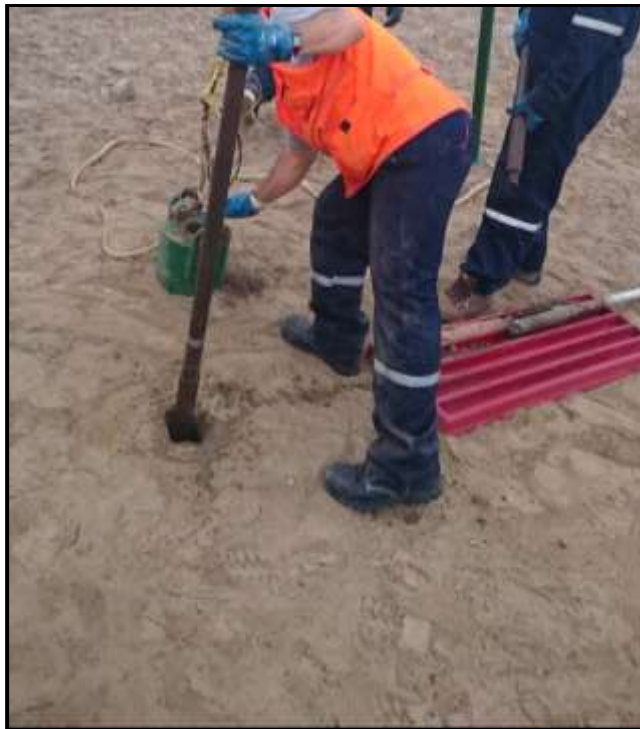
Figura 3. Colocación de la caña partida en el suelo perforado.
