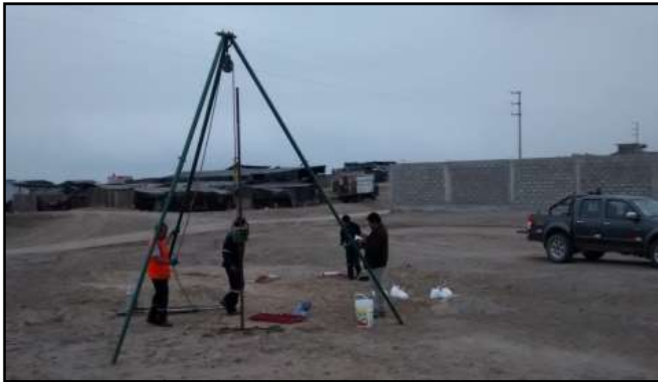
Figura 16. Vista del ensayo SPT-02, realizado en el segundo punto.
