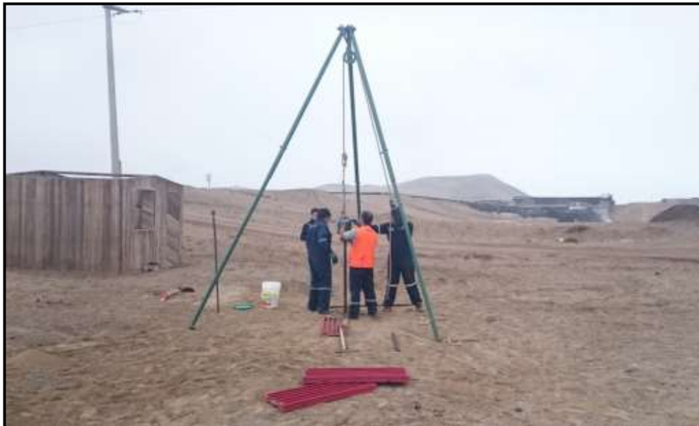
Figura 15. Vista del ensayo SPT-01, se puede observar al personal preparando el equipo para comenzar con el ensayo de penetración estándar.
