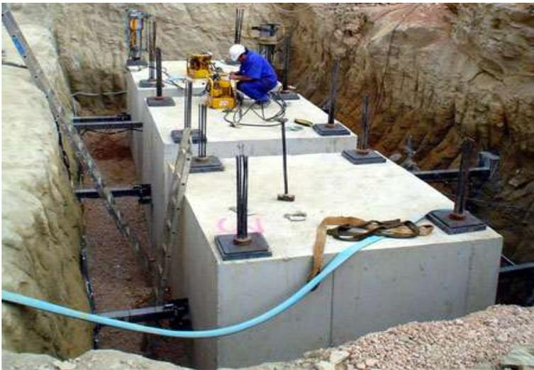
Figura 16. Ensayo de Corte Directo In Situ
