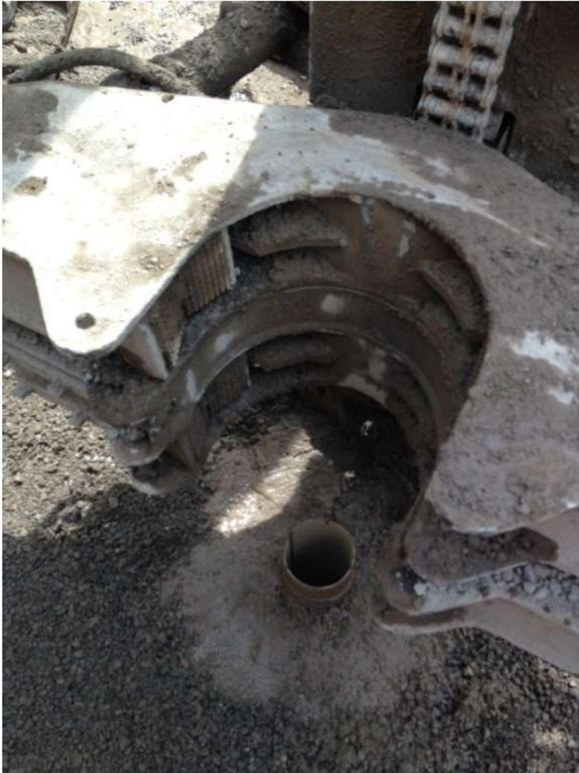
Figura 62. Colocado y cementado de la tubería inclinométrica con lechada de cemento.
