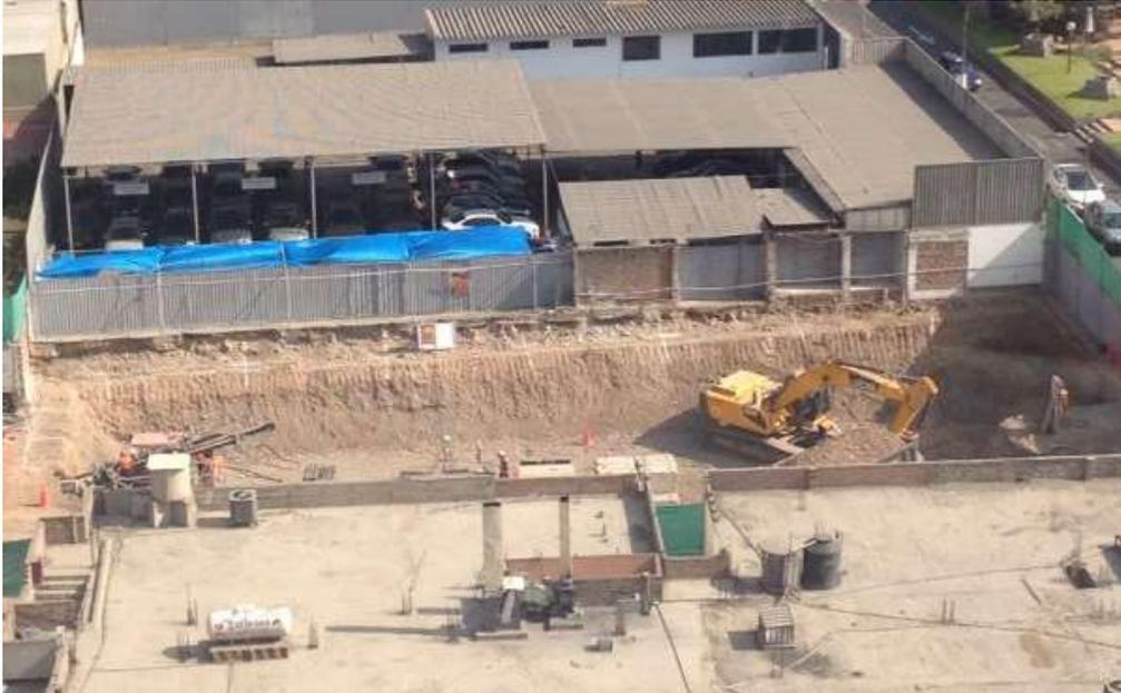
Figura 47. Excavación masiva hasta el primer nivel de excavación.
