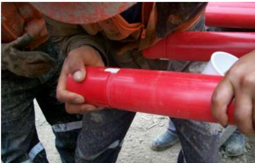
Figura 61. Detalle del tapón de fondo de la tubería inclinométrica.
