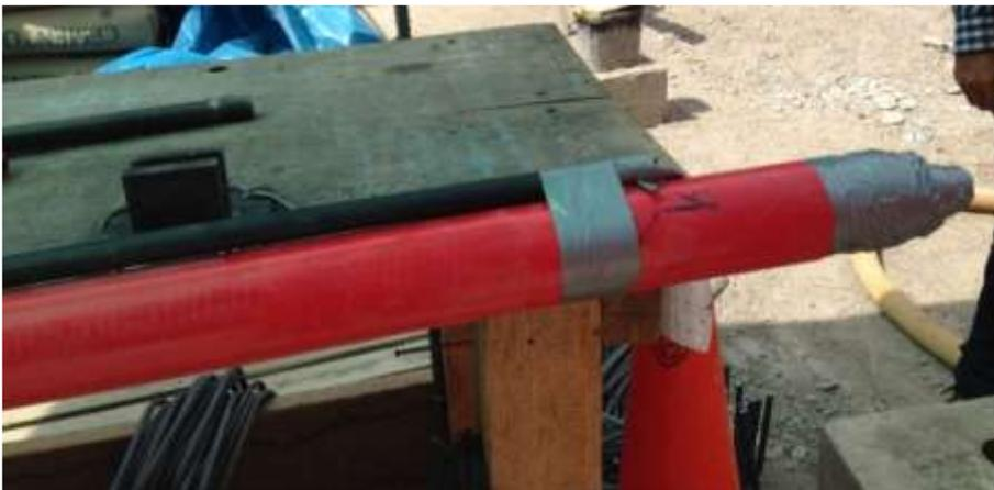
Figura 59. Tubo Pead para inyección de lechada con perforaciones para mejorar la inyección. Tomado de "Protocolos de Monitoreo Inclinométrico," por Pilotest Terratest Perú (PTP), 2015.
