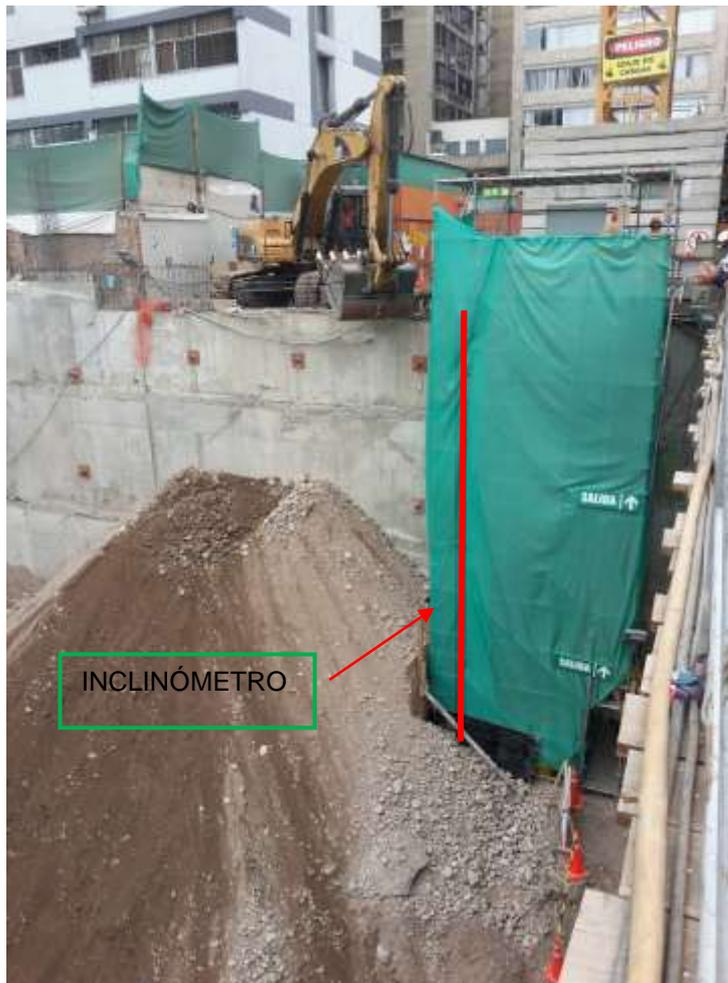
Figura 81. Vista de material apilado sobre el muro de la zona instrumentada.
