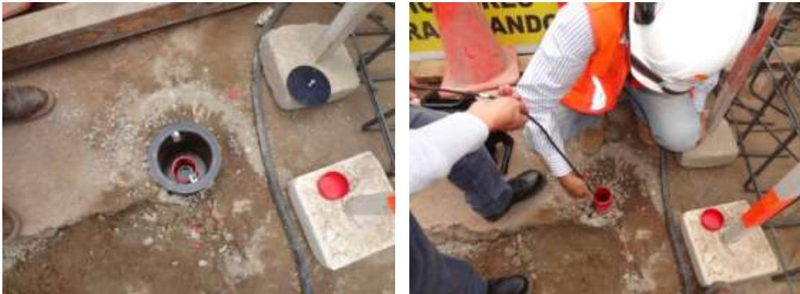
Figura 63. Se quita la tapa de seguridad de la tubería inclinométrica.
