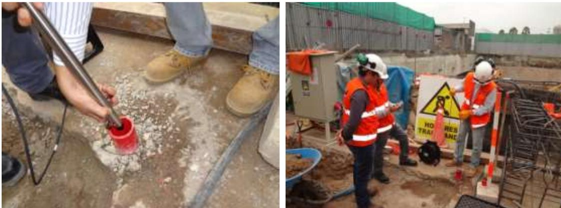
Figura 64. Introducción de la sonda en la tubería, haciendo uso de las acanaladuras de la tubería para las ruedas de la sonda. Tomado de "Protocolos de Monitoreo Inclinométrico," por Pilotest Terratest Perú (PTP), 2015.
