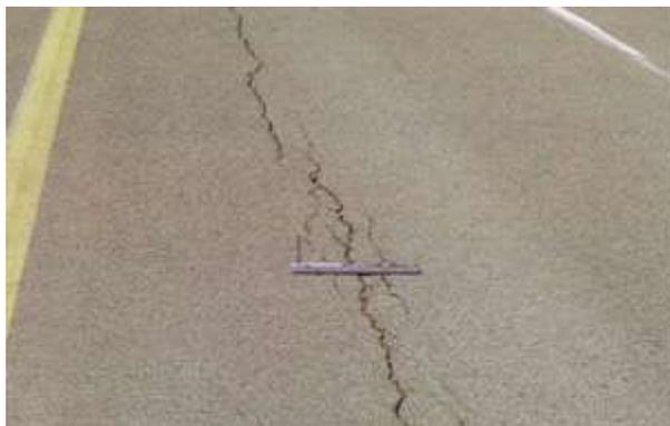
**Figura 2.5 Fisuras y grietas: fisura longitudinal a lo largo de la huella del tránsito**
