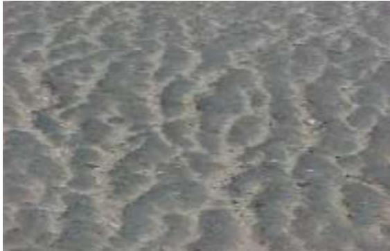
**Figura 2.7 Deformaciones: corrimiento**
