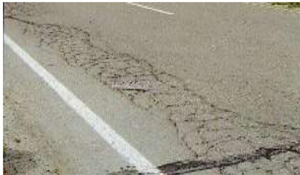
**Figura 2.2 Fisuras y grietas: piel de cocodrilo**
