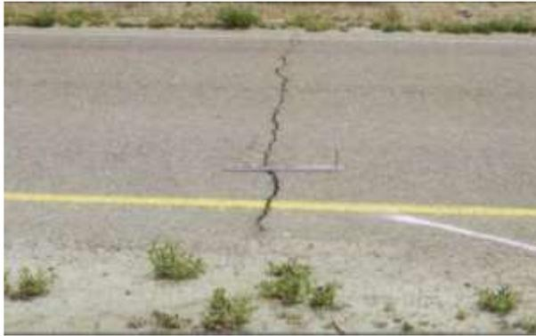
**Figura 2.4 Fisuras y grietas: fisura transversal, atraviesa toda la sección de la carretera**
