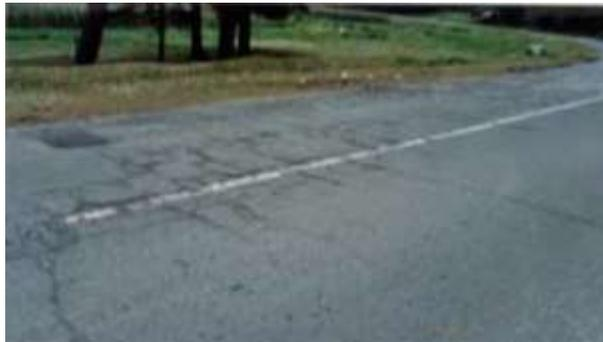
**Figura 2.3 Fisuras y grietas: fisuras en bloque**
