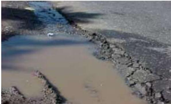
**Figura 2.13 Desintegración: desintegración en bordes con acumulación de agua**
