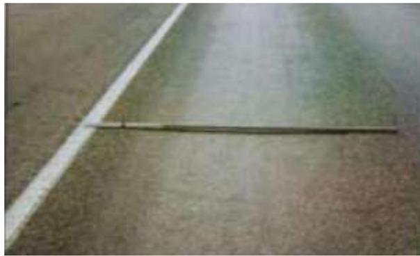
**Figura 2.6 Deformaciones: Ahuellamiento**
