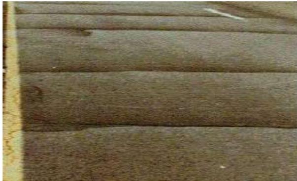
**Figura 2.8 Deformaciones: corrugación**
