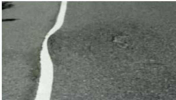
**Figura 2.10 Deformaciones: hundimiento**
