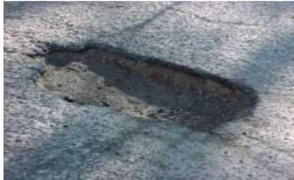
**Figura 2.11 Desintegración: bache, con pérdida de material de base**
