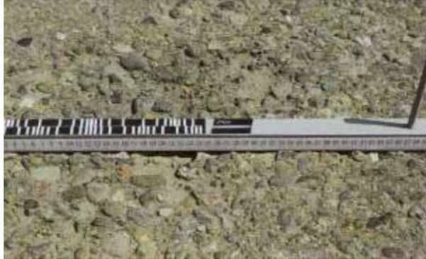
**Figura 2.12 Desintegración: peladura en pavimento**
