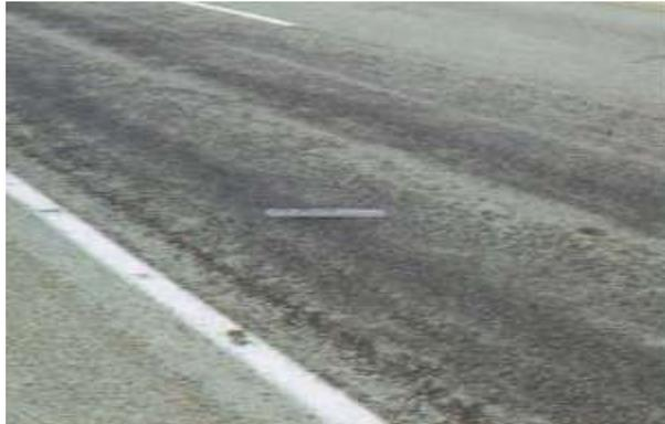
**Figura 2.14 Exudación de asfalto**
