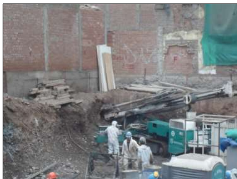
2° ETAPA – PERFORACIÓN Y ANCLAJE
