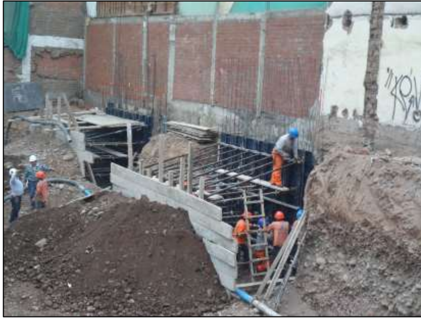
3° ETAPA – ENCOFRADO Y VACIADO DE MURO
