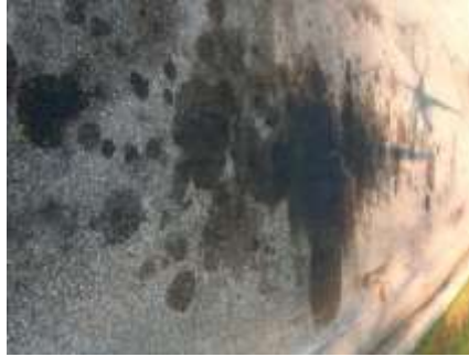
Falla 9: Derrames de aceite y/o líquidos disolventes
