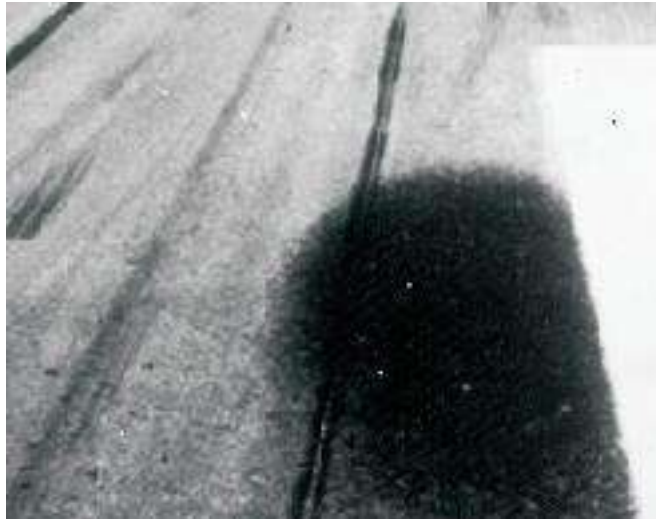
Falla 6: Erosión por fatiga
