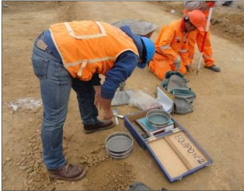
Fotografía N°5: Técnico realizando el ensayo de densidad de campo, Fuente: Resumen fotográfico de la Obra Alameda en la Av. Santa Rosa en San Juan de Lurigancho tramo Av. Próceres de la independencia – Av. Canto Grande.
