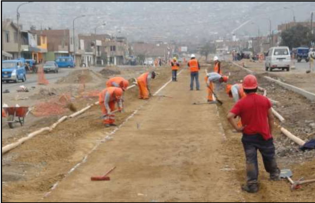
Fotografía N°1: Cuadrilla realizando excavación manual, Fuente: Resumen fotográfico de la Obra Alameda en la Av. Santa Rosa en San Juan de Lurigancho tramo Av. Próceres de la independencia – Av. Canto Grande.
