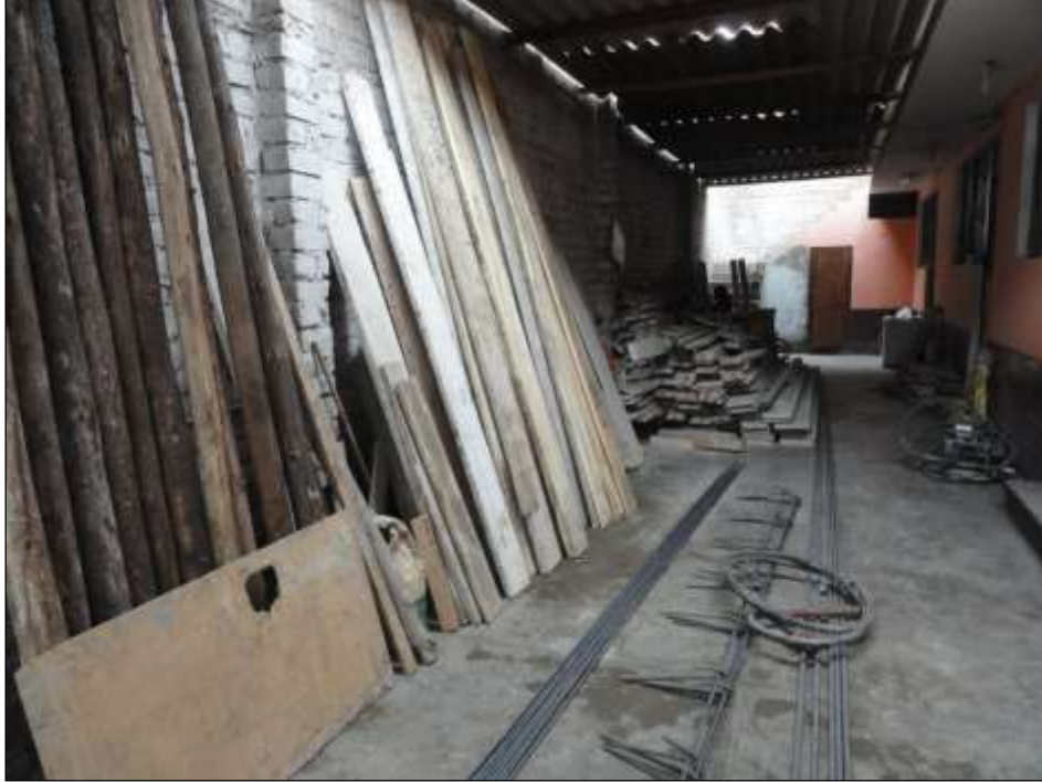
Fotografía N°3: Almacén de Obra, Fuente: Resumen fotográfico de la Obra Alameda en la Av. Santa Rosa en San Juan de Lurigancho tramo Av. Próceres de la independencia – Av. Canto Grande.
