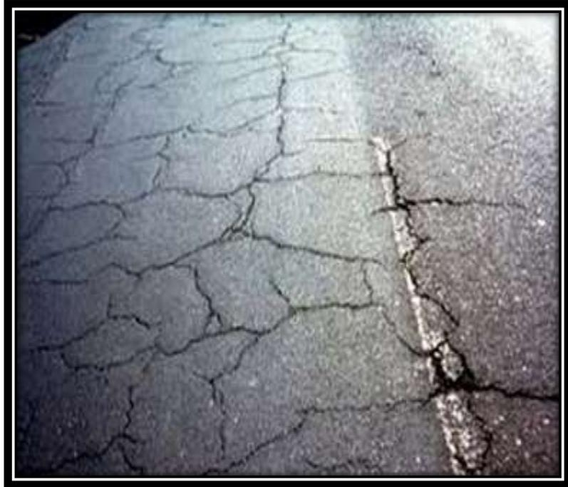
**Figura 13. Fisura en Bloque**
