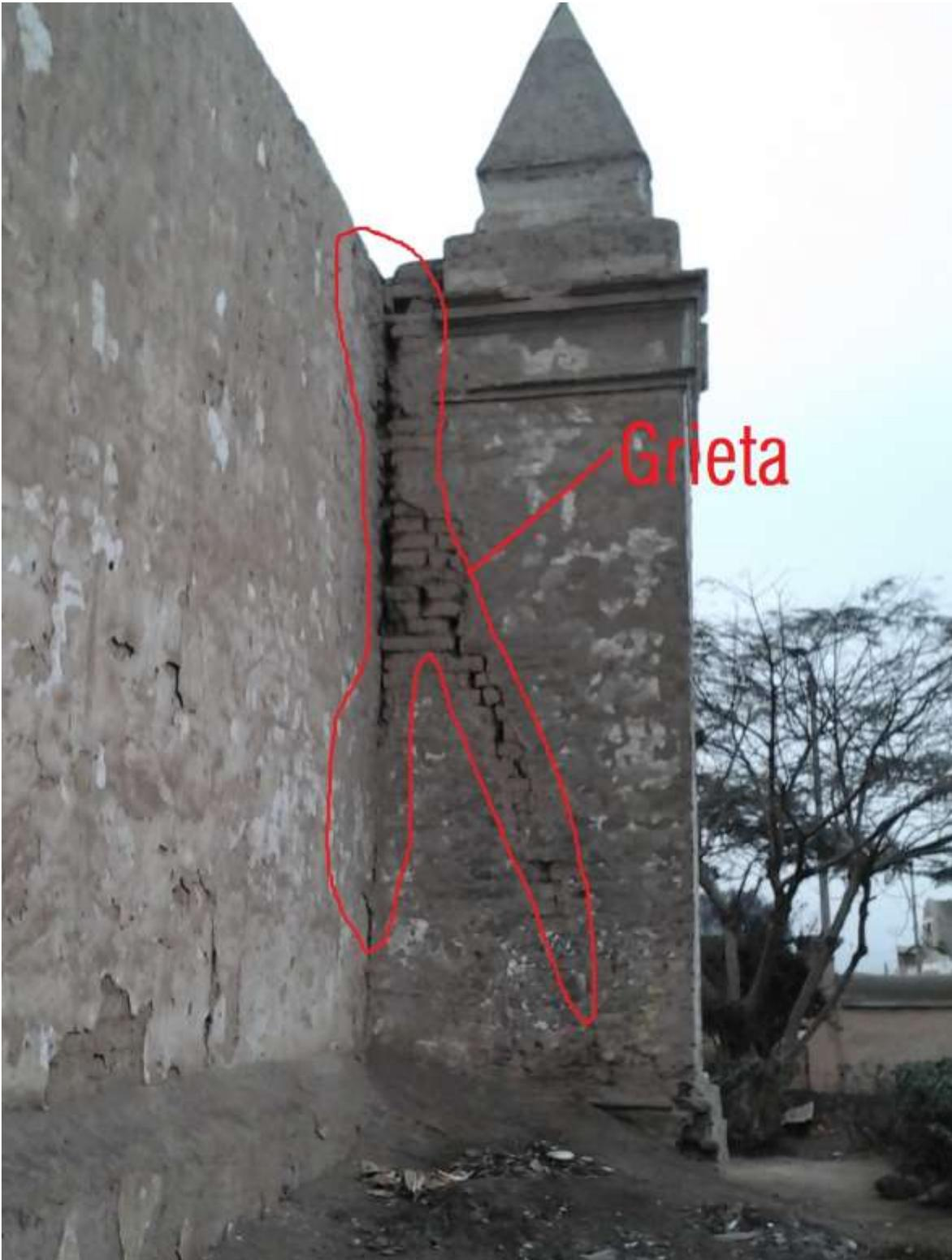
Ilustración 19: Fisura encuentro de muro con esquina
