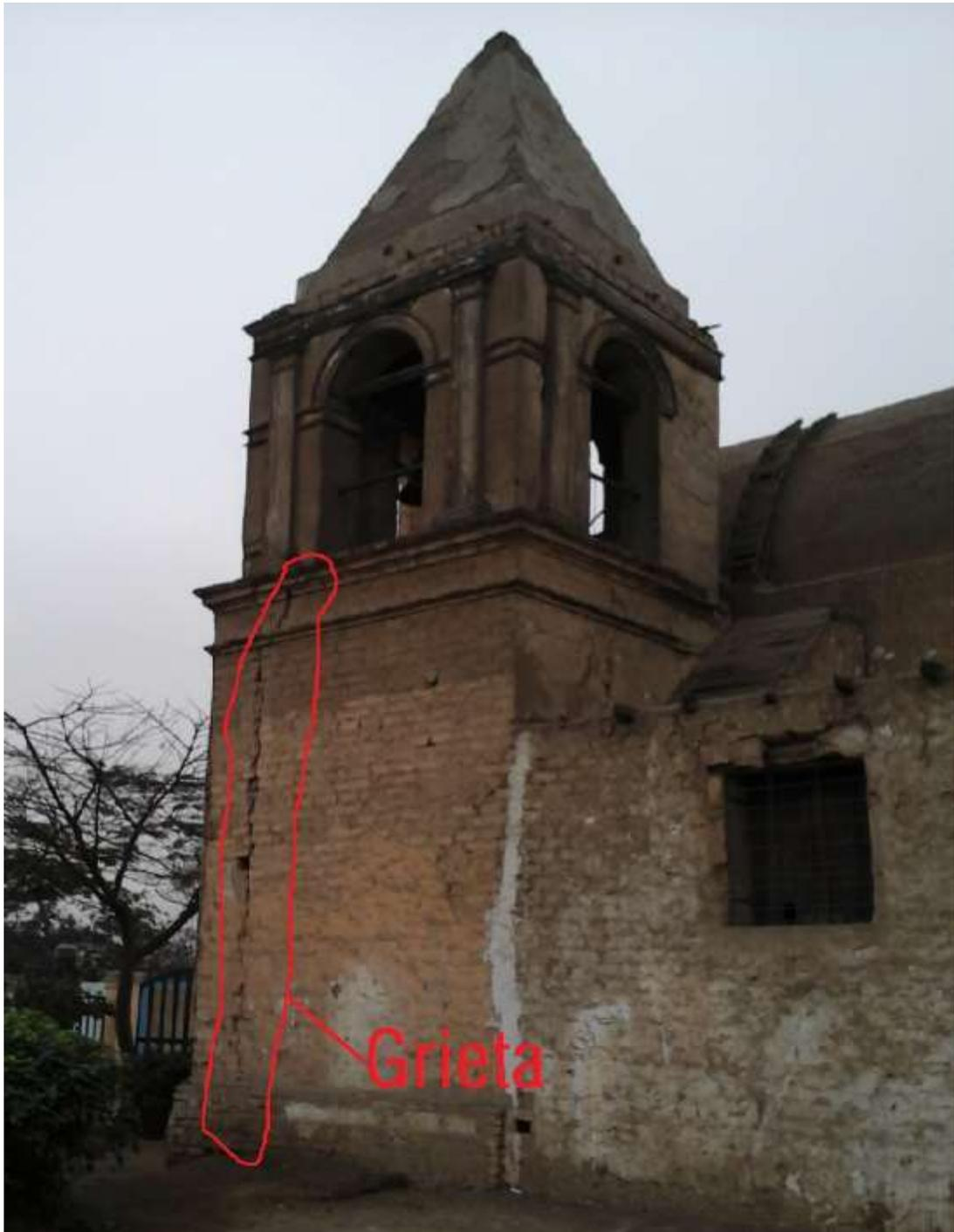
Ilustración 13: Vista de fisuras en campanario, lado derecho
