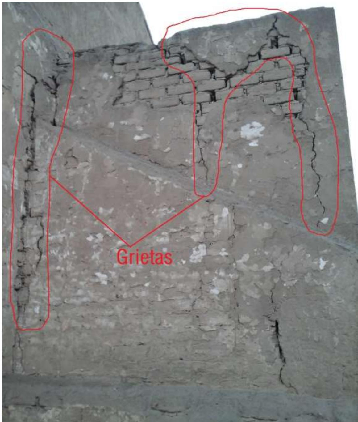
Ilustración 20: Fisura en muro lateral derecho de la sacristía
