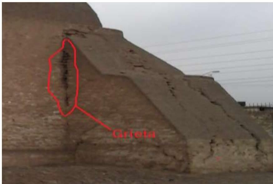
Ilustración 15: Fisura en cambio de sección, lado derecho
