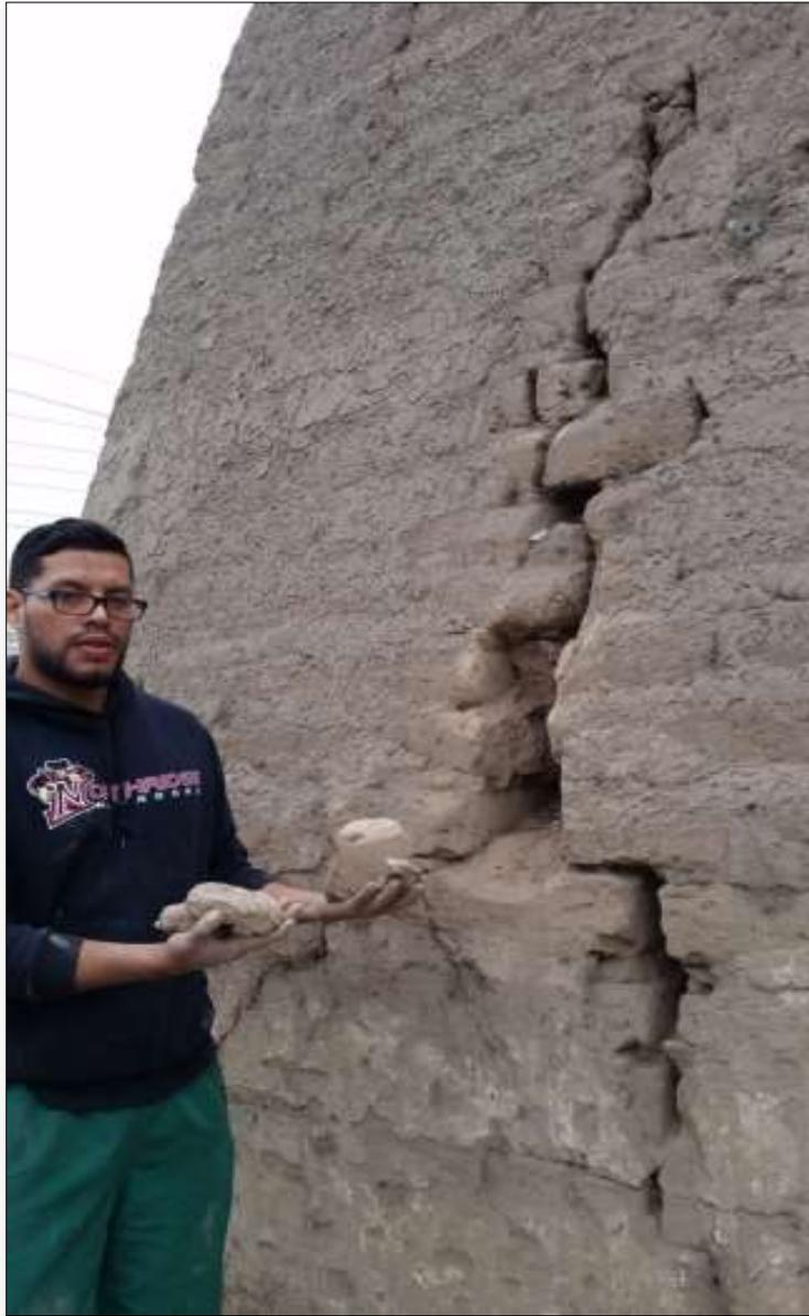
Se ensayaron 03 muestras de distintos bloques de adobe extraído de la estructura: Muestra 01, 03 y 04
