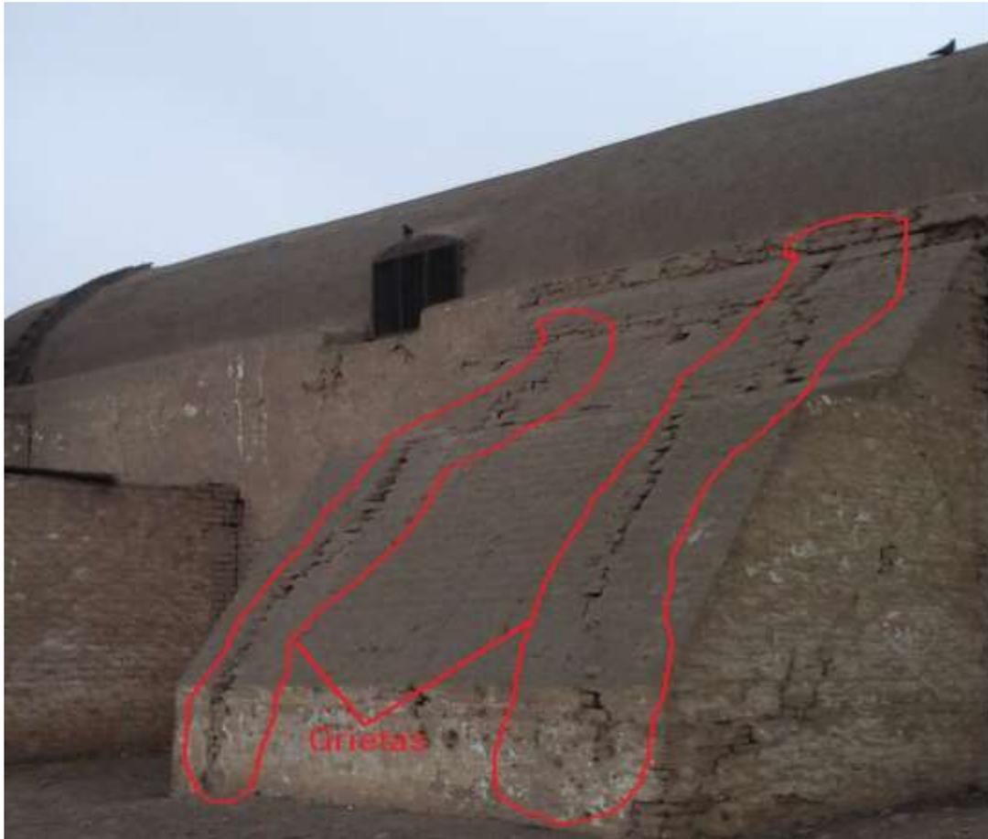
Ilustración 11: Vista de fisuras contrafuerte, lado izquierdo
