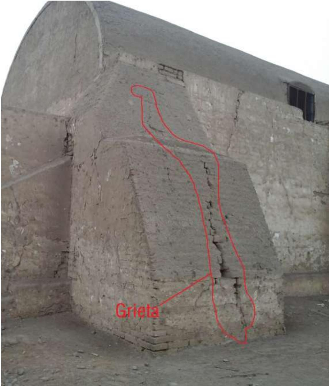
Ilustración 16: Vista de fisuras contrafuerte, lado izquierdo
