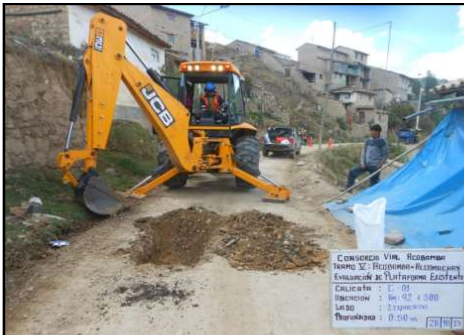
Figura 32. C-01, Calicata Superficial (0.50 m) sólo para caracterización geotécnica del afirmado existente
