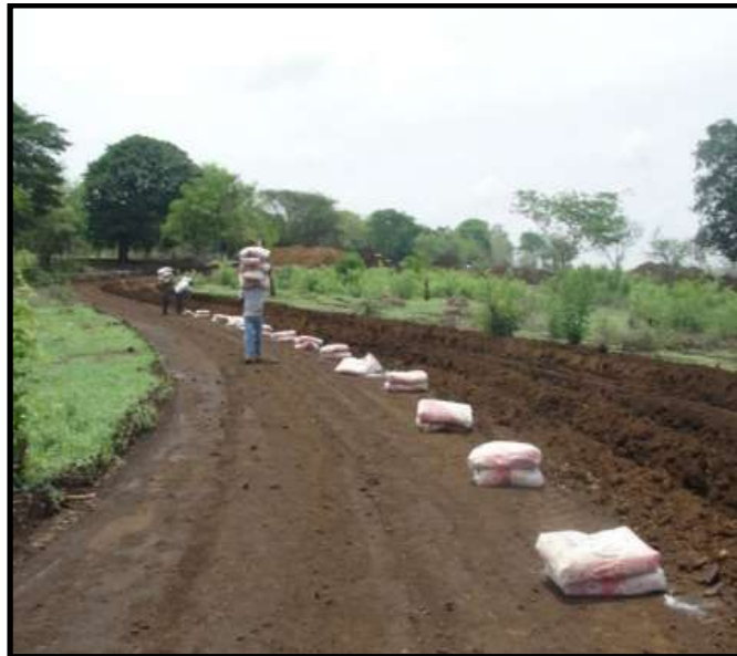
Figura 10. Estabilización con cloruro de magnesio.
