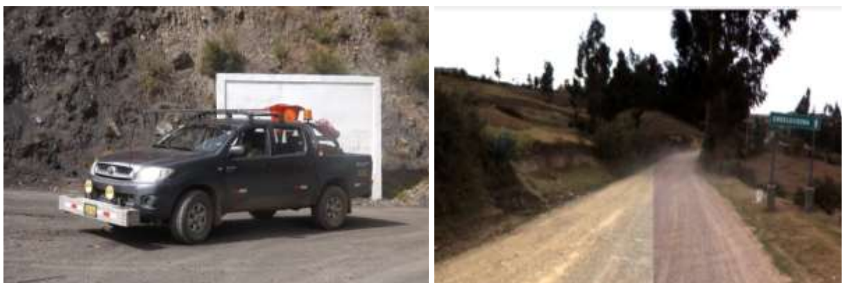
Figura 26. Superficie del tramo Acobamba - Emp. PE 3S (Puente Alcomachay)
