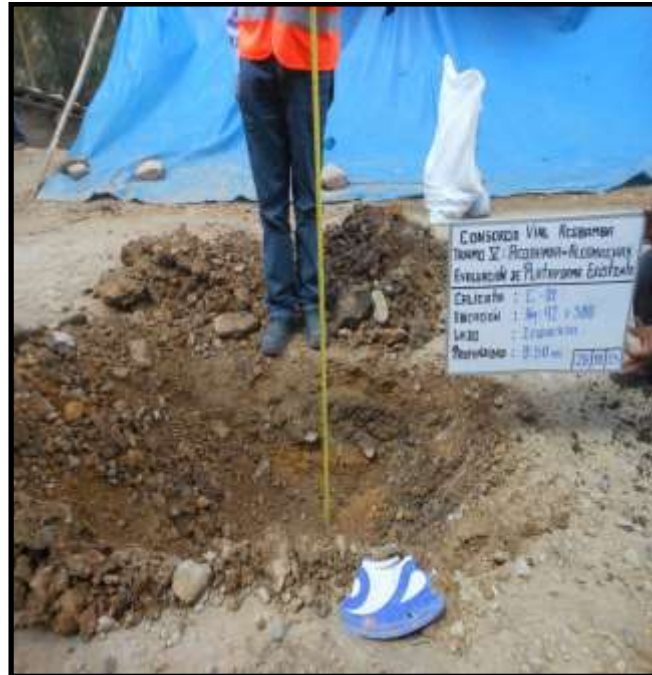
Figura 31. C-01 Profundidad 0.5 m / km 92+300 (L.I.)
