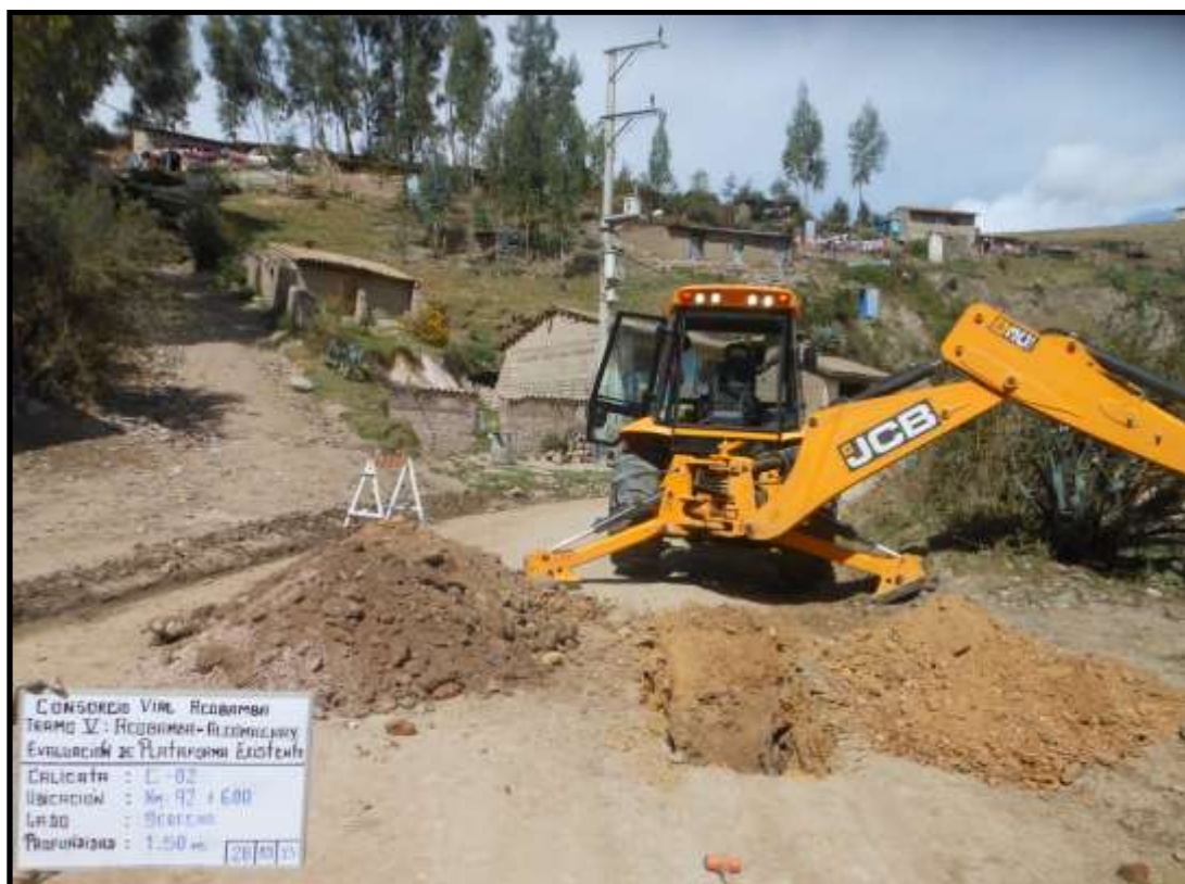
Figura 34. C-02, Calicata Profunda (1.50 m) para caracterización geotécnica del paquete estructural del pavimento
