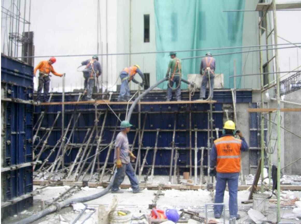
La foto nos muestra la placa de 0.15 m del Eje A, en pleno proceso de vaciado , esto como lo dijimos antes , lo realizábamos al día siguiente del vaciado de la losa. Luego de vaciada la placa , ésta era revisada para ver su alineamiento vertical
