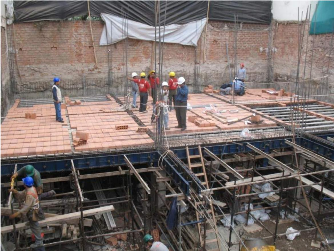
La foto muestra el vigueteado en su parte final y la colocación de los ladrillos respectivos. Estos ladrillos están diseñados para que se anclen a las viguetas , evitando de esta manera cualquier desplazamiento , así mismo las viguetas están provistas del acero positivo y negativo , dentro de su estructura, evitando del mismo modo cualquier tipo de desplazamiento en el momento de vaceado.
