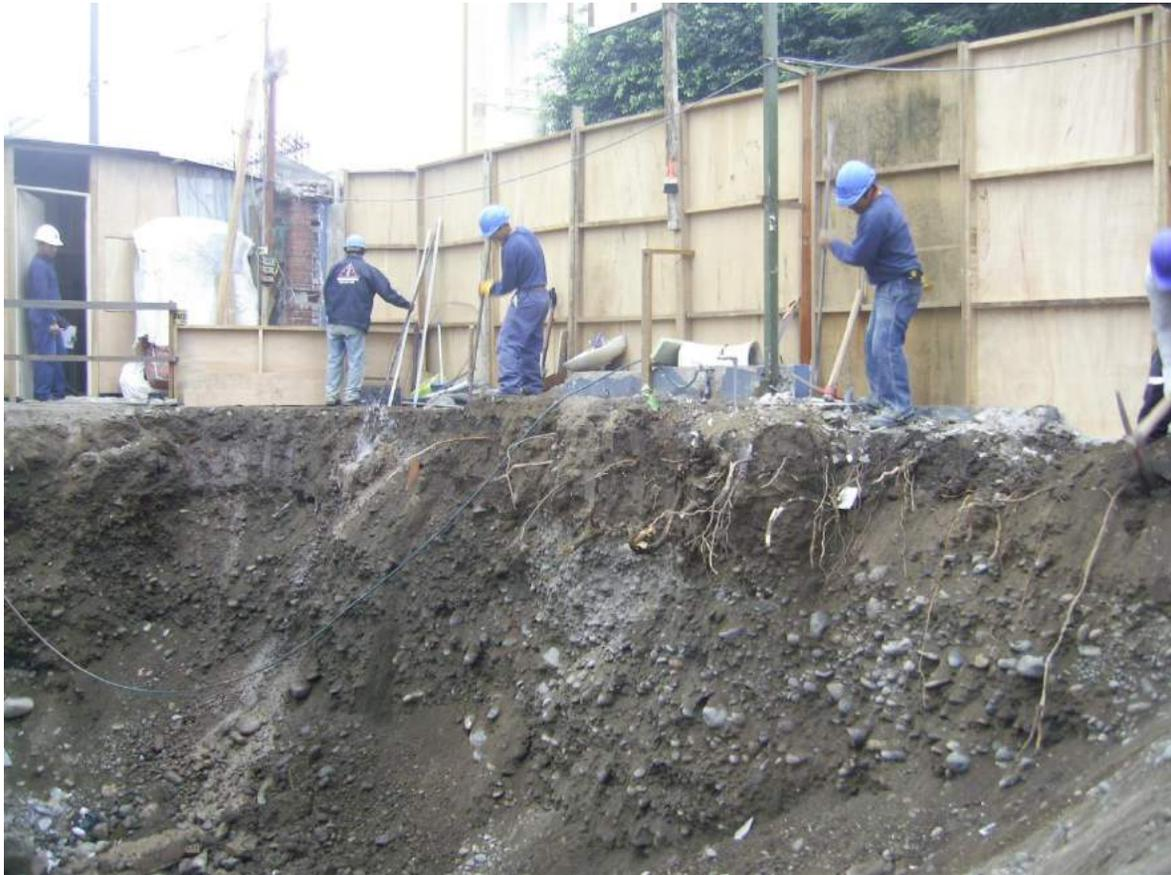
La excavación de la parte delantera se hizo con mucho cuidado por estar muy cerca de la vereda exterior.
