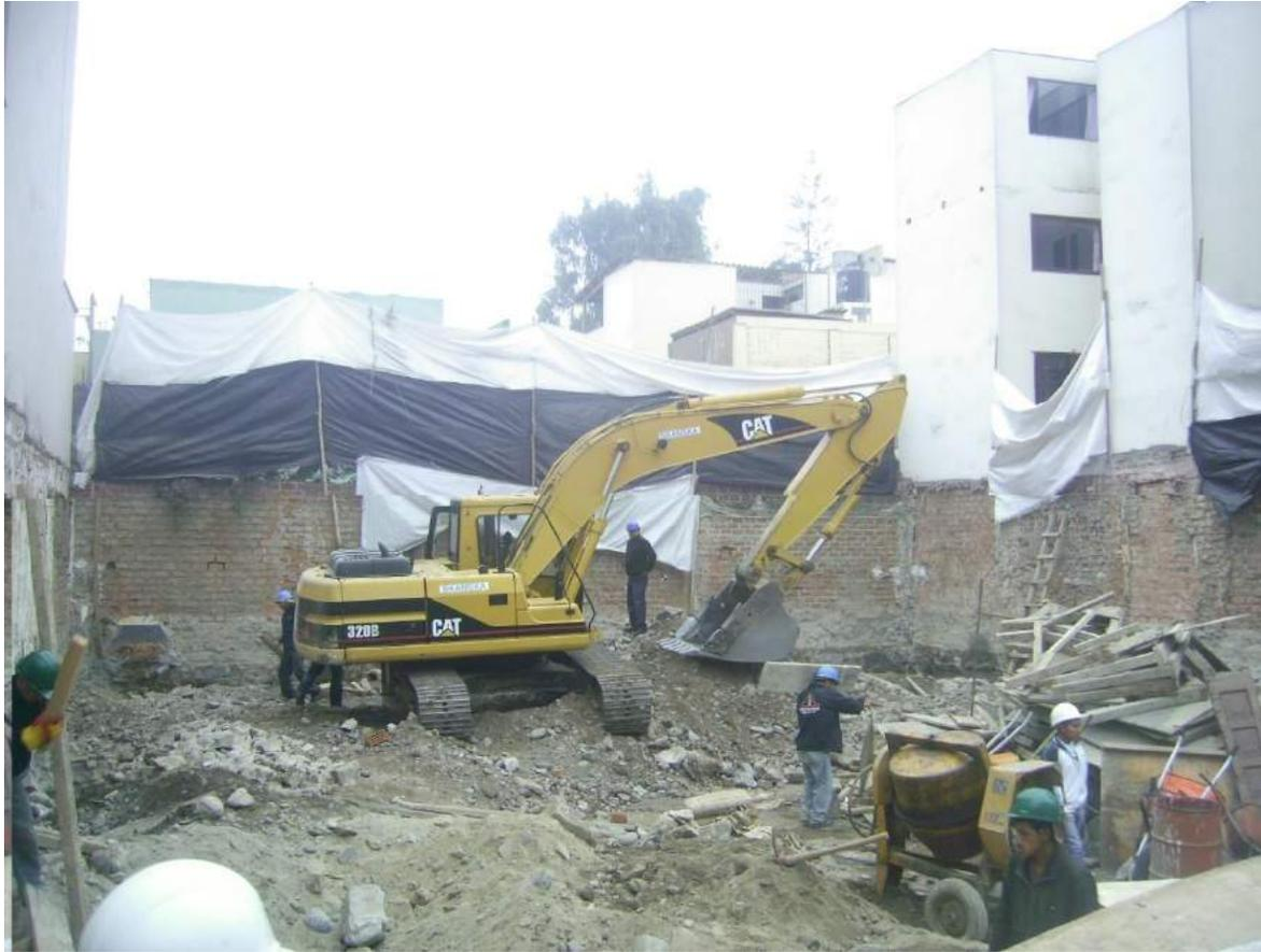
La maquinaria pesada, acumulaba el material sobrante, para luego depositarlo en la tolvas de los camiones para ser retirados de la Obra , para ello se construyó una rampa de acceso con el mismo material.
