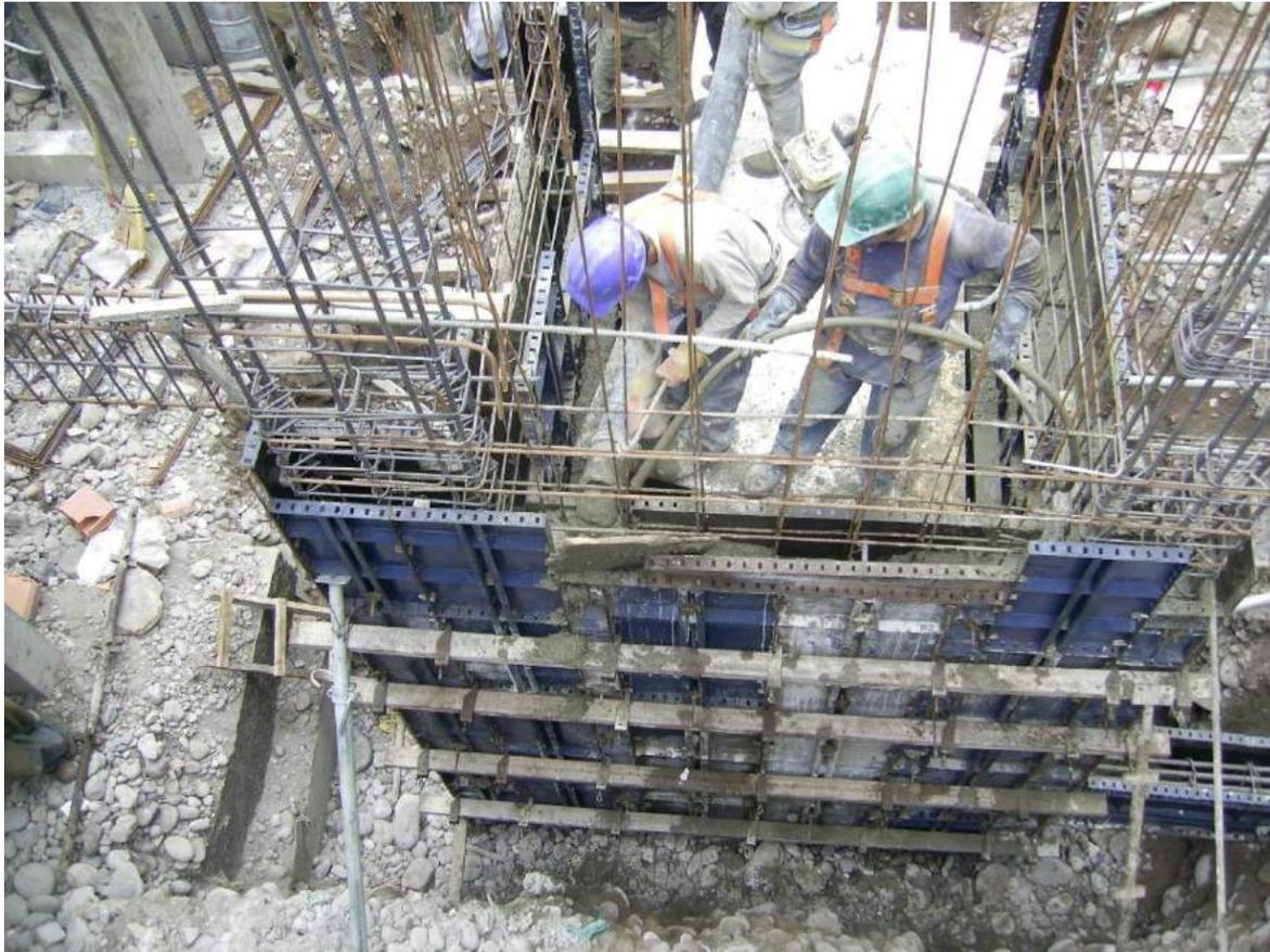
Una vez verificado los ejes de la correcta ubicación , se verificó los aceros de refuerzo de la placa de ascensor, así mismo se verificó la plomada del encofrado y los correspondientes recubrimientos .
