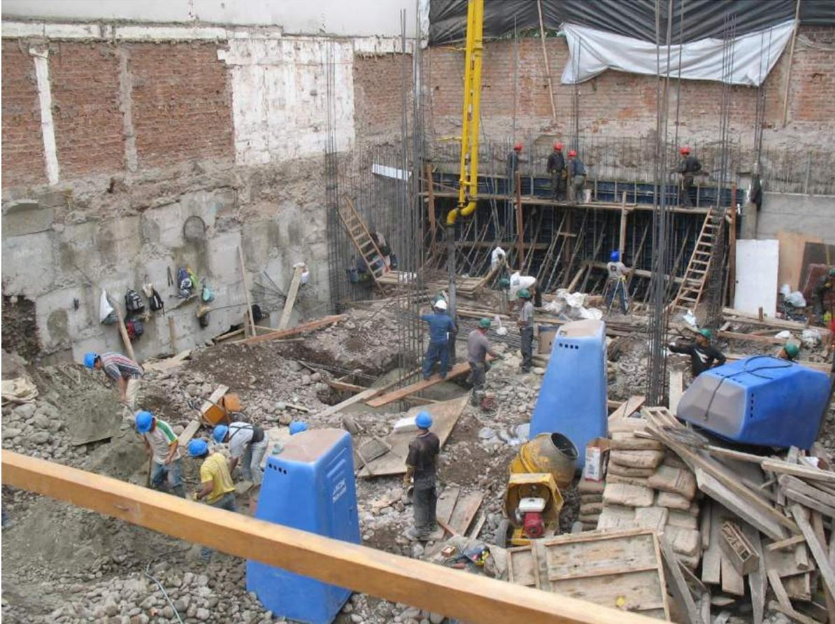
La foto nos muestra el término de vaceado del muro de contención y de la zapata de la columna C-2 del eje B y C y eje 4 , tener en cuenta que siempre hay que aprovechar el máximo volumen a vacear , para nuestro caso se vació un muro de 0.25 m y 2 zapatas que en volumen representaba 15 m<sup>3</sup> . La empresa concretera tiene un volumen mínimo de vaceado con bomba de 14 m<sup>3</sup> , de no alcanzar dicho volumen se tenía que pagar la diferencia entre éste y el volumen requerido.
