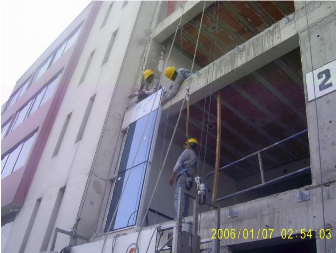
La foto presenta la colocación del 1er paño del muro cortina , nótese la fijación de ésta a los anclajes en las vigas previamente instaladas.
