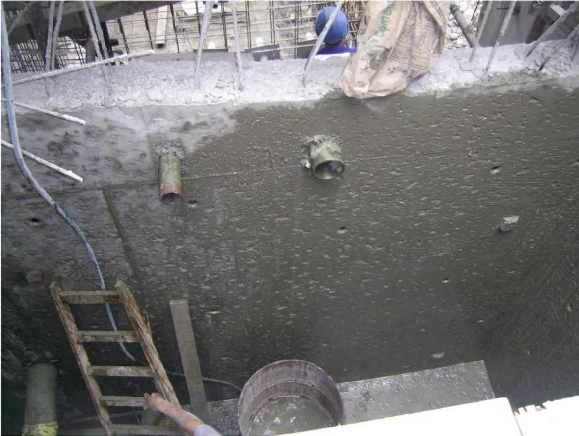
La foto nos muestra la pared de la cisterna , con unos pequeños agujeros en su superficie , esto es , con la finalidad de que mortero 1:4 con impermeabilizante, pueda adherirse mejor, cuyo espesor fué de 1.2 cm
