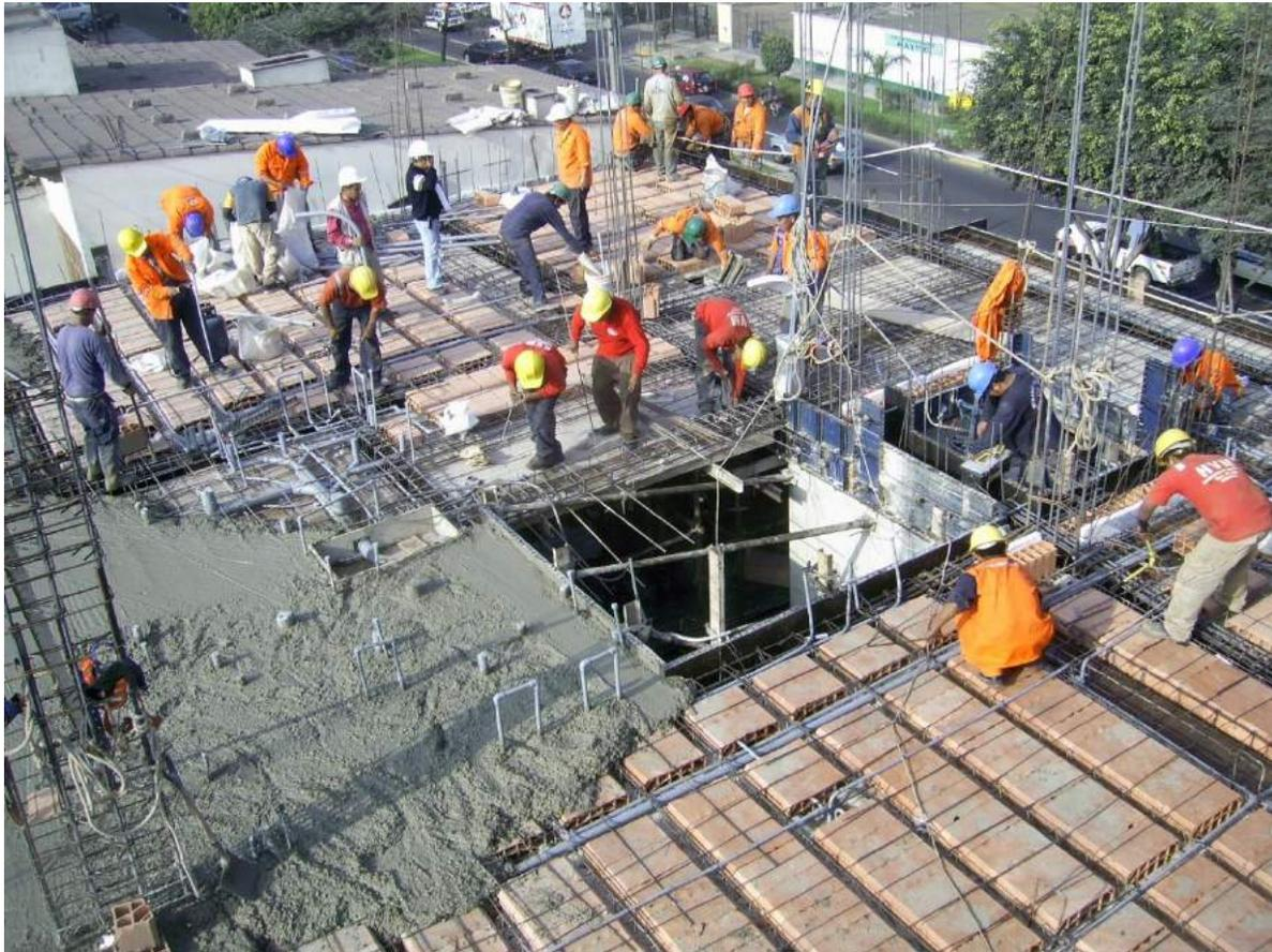
La foto nos muestra al personal ejecutando las labores finales a los paños delanteros , nótese que todavía no se ha encofrado la escalera para su vaciado . Esto no se realizó por no contar con el suficiente personal de fierro., se coordinó con el subcontratista de acero para que nos provea mas personal a fin de vacear la losa con su respectiva escalera.
