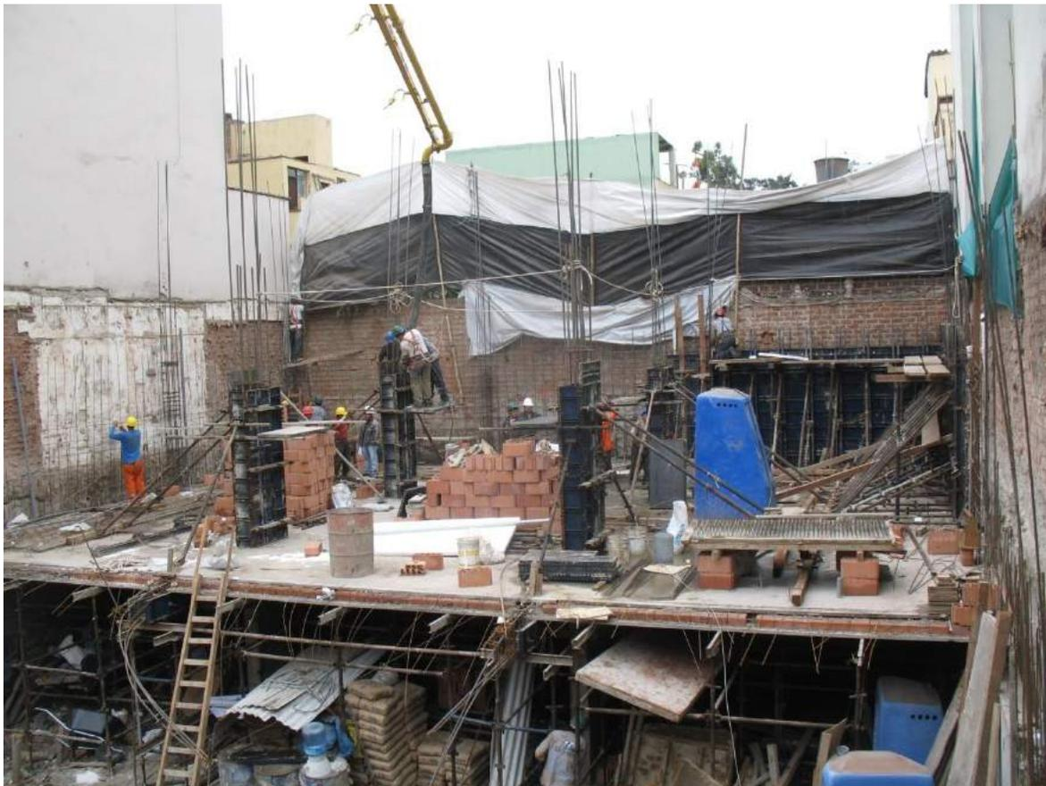
Observamos en la foto el vaciado de la columnas C-1 y C-2 y el encofrado del muro de contención del eje 6.
