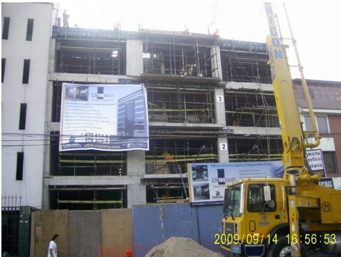
La vista nos muestra la facha principal de la Av. Encalada en pleno vaceado de la losa del 4º nivel. Nótese el encofrado metálico de los pisos inferiores
