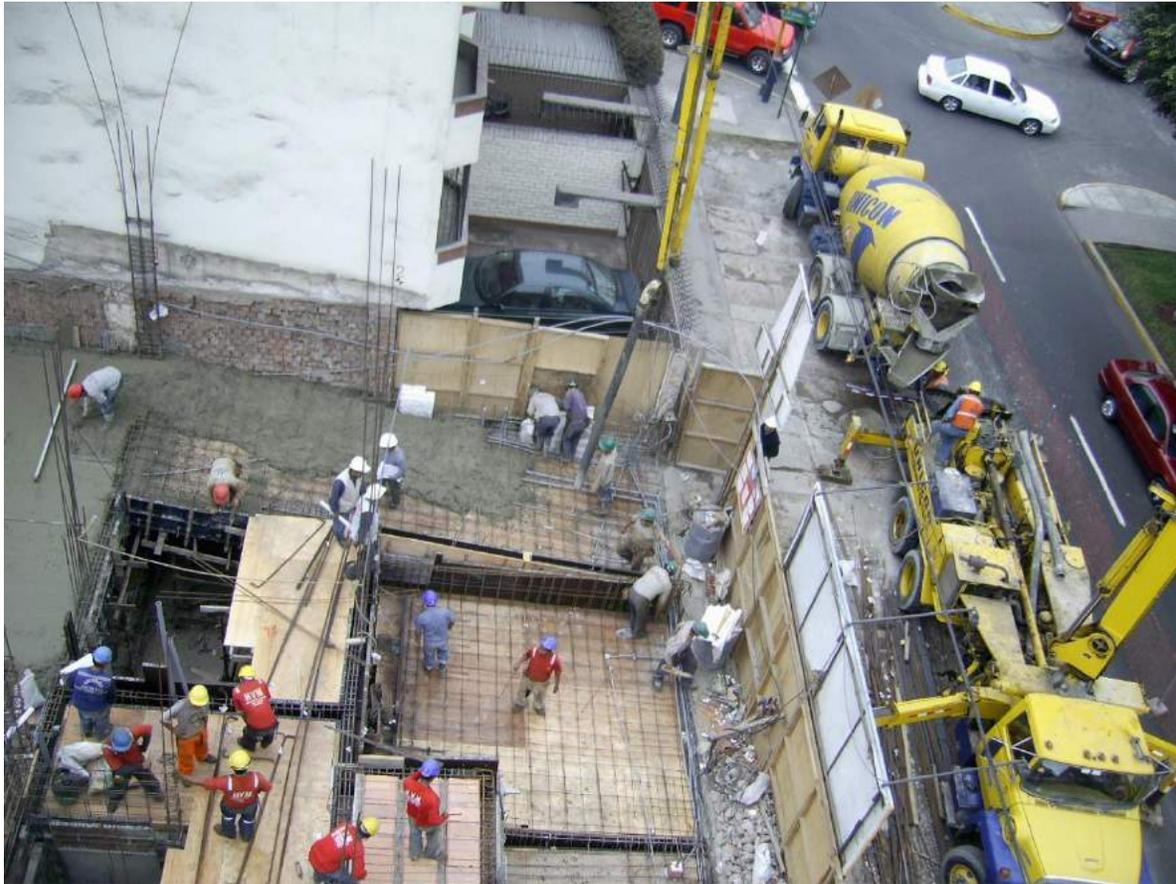
Nótese a personal en pleno proceso de vaceado de la losa faltante y las rampas de ingreso. Con este vaceado nos nivelamos en cuanto a las losas y de allí se empezaron a llenar techos cada 4 días. En el siguiente orden :
