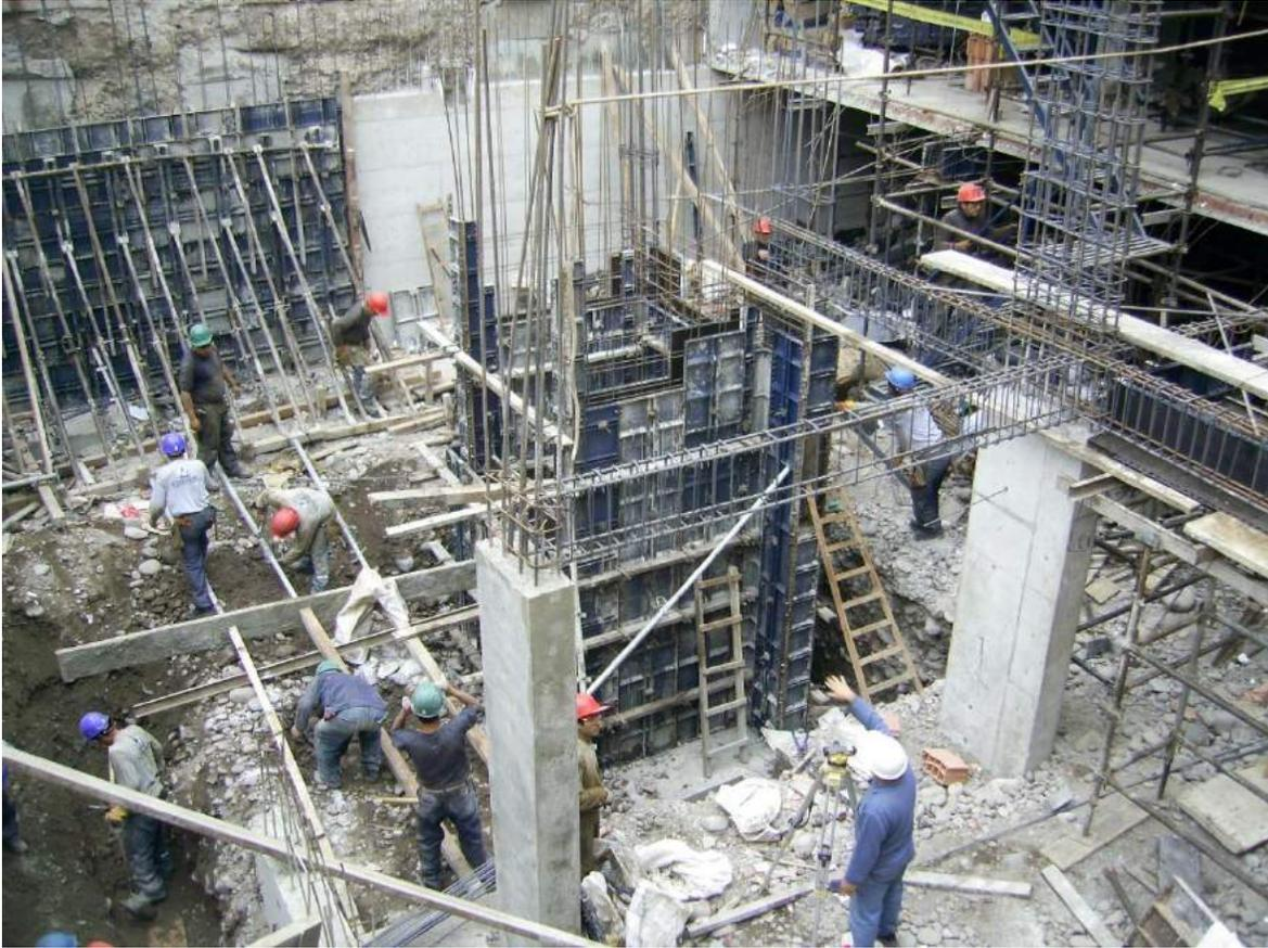
En la vista siguiente, se ha terminado de colocar el encofrado en el ascensor y se encuentra listo el muro de contención del eje 1 para su vaciado. En todo momento se verifica los niveles de vaciado con el nivel topográfico.
