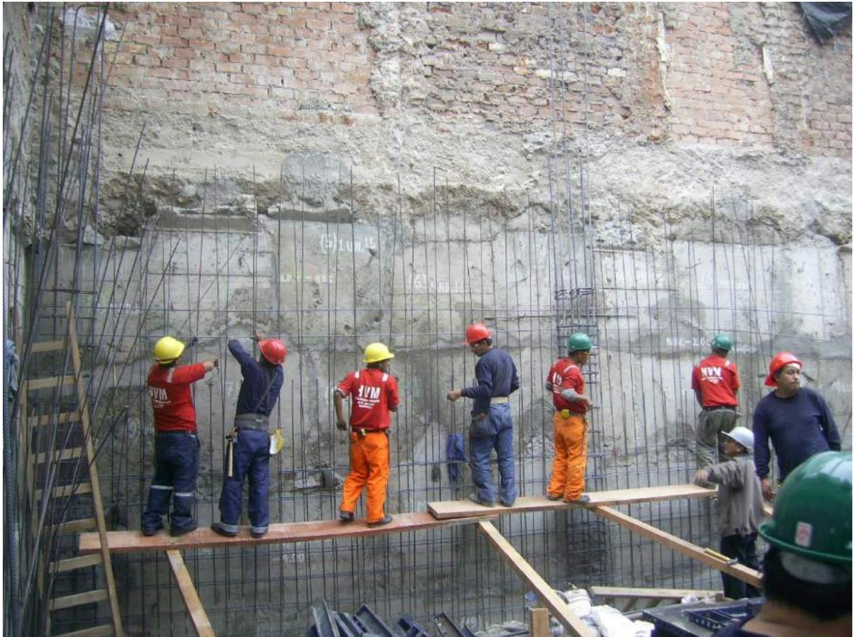
Una vez vaciado el solado en la cimentación del muro de contención, se procedió a colocar el acero dimensionado .
