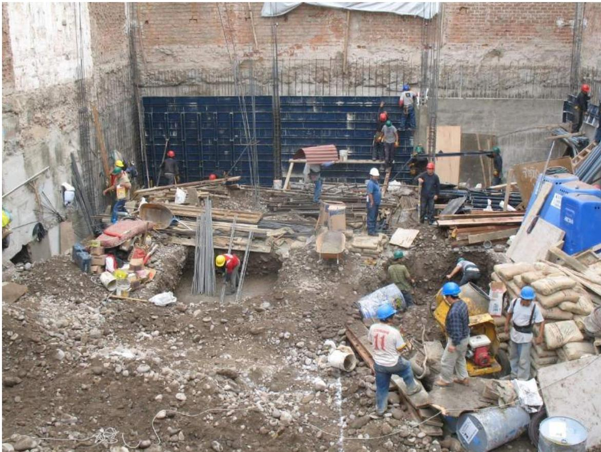
La foto muestra el encofrado de la última parte del eje 6 , nótese que ya se han vaceado el solado de las zapatas en la columnas C1 , siempre la cuadrilla de acero está por delante de los encofradores por los menos 1 día, con la finalidad de dejar frente a los que vienen por detrás. Por lo ajustado del terreno, todavía existe una buena parte por eliminar desde la parte central media hacia delante ( falta excavar caja de ascensor y cisternas de agua contraincendio y de
