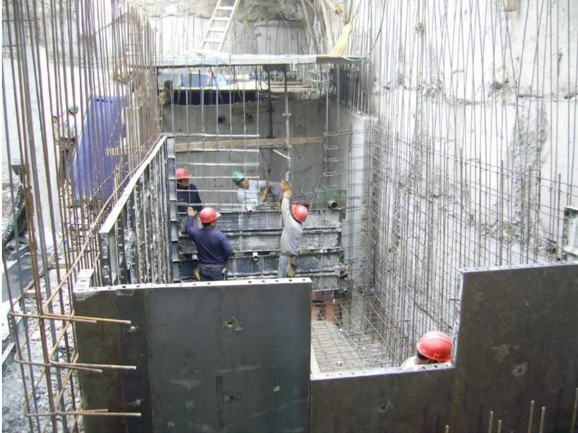
Nos muestra al personal encofrando la cisterna de consumo y parte del cuarto de máquinas, importante notar que los techos tanto de la cisterna de agua contra incendio, cuarto de máquinas y cisterna de consumo , estarán formando la rampa de forma semicircular , que comunicará al sótano con el semisótano , vale decir cotas del -1.35 mts al - 4.05 mts
