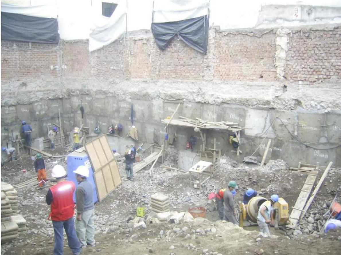
Nótese en la foto el tercer anillo terminado de los ejes D y 6 . Como puede apreciarse en la foto el material del terreno
