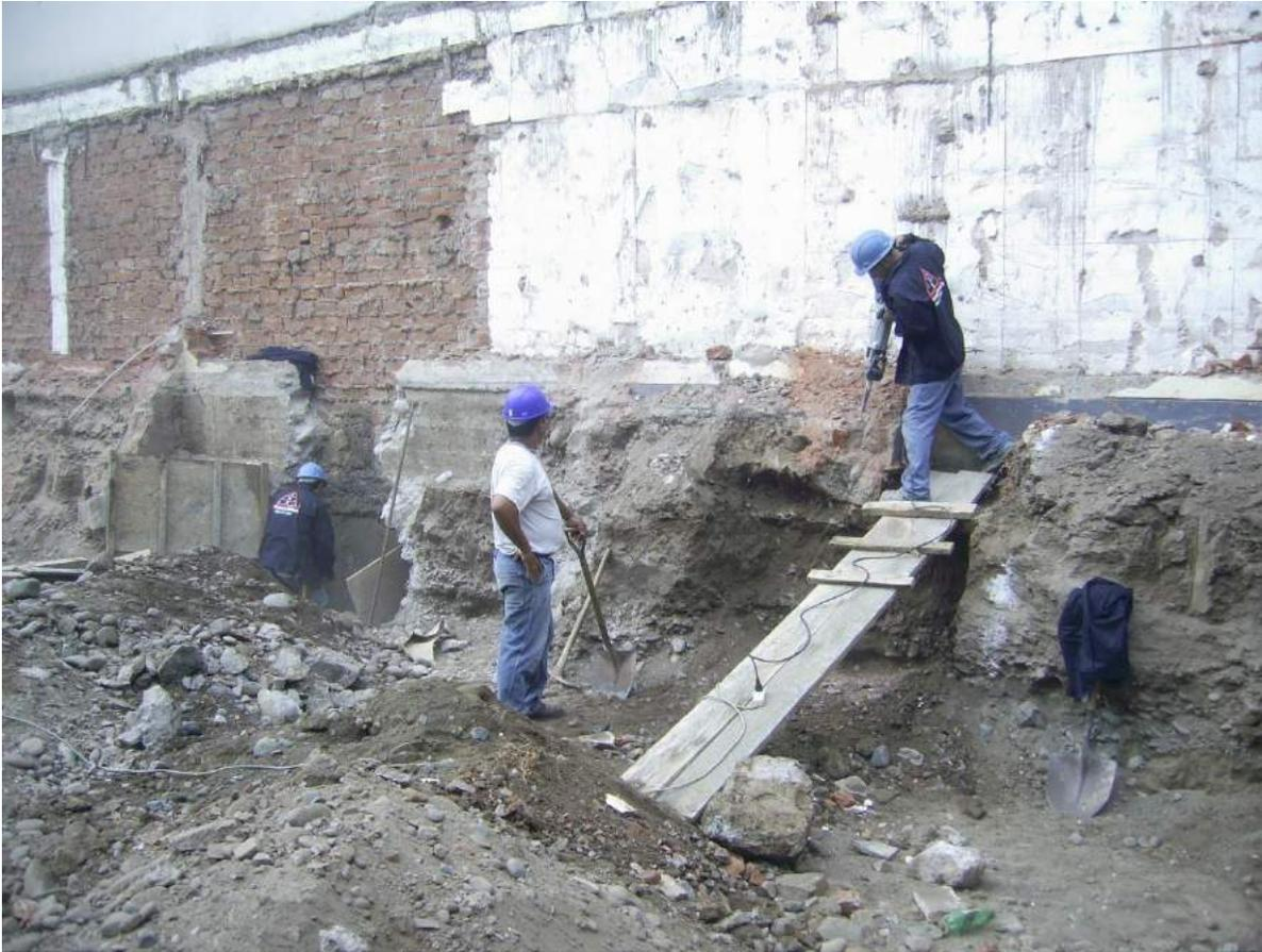
Personal en pleno proceso de la excavación para las calzaduras. Nótese que los paños son alternados y tienen una secuencia de vaceado.
