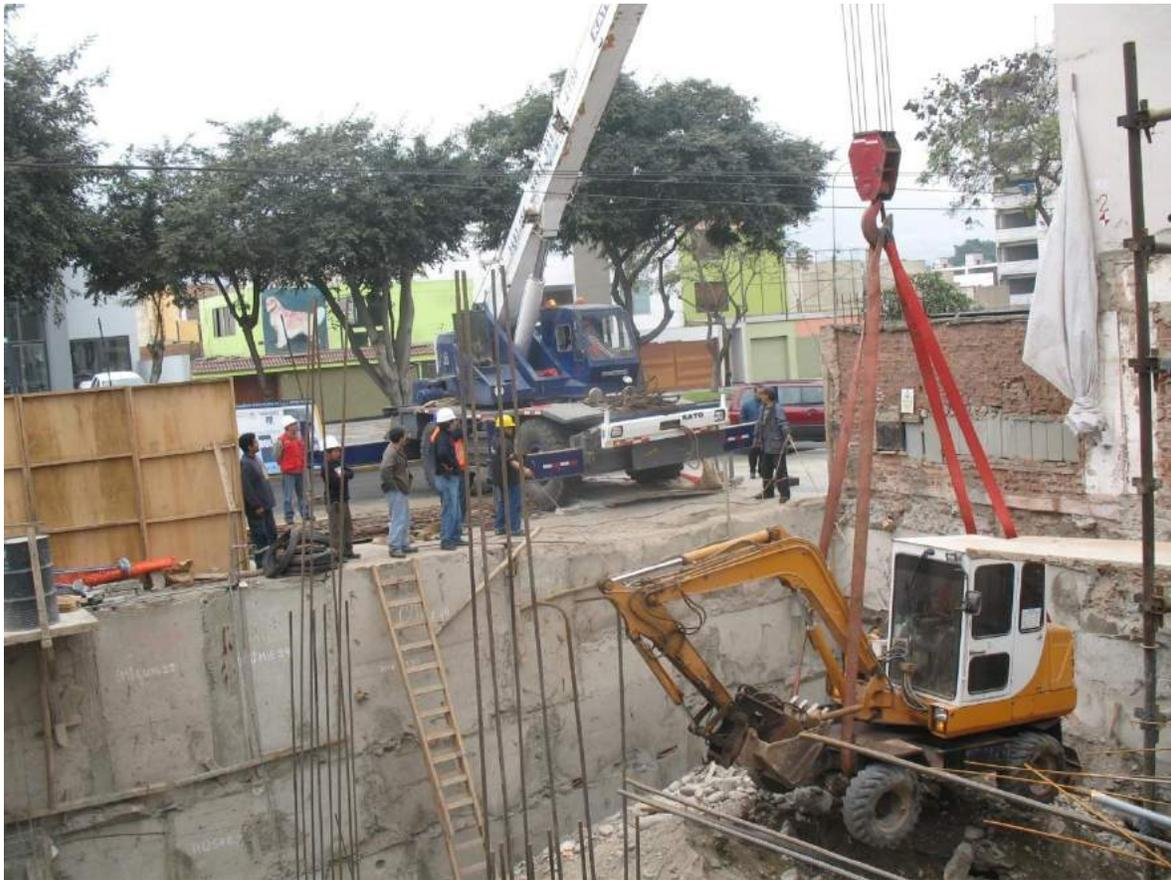
El equipo ya se encontraba en posición para iniciar los trabajos , la idea era excavar lo máximo posible y arrimar el excedente a la esquina , para que de éste modo, la excavadora de oruga, desde arriba con el brazo totalmente extendido pueda recoger el material y depositarlo en los volquetes, que se encontraba paralelos a la Avenida.
