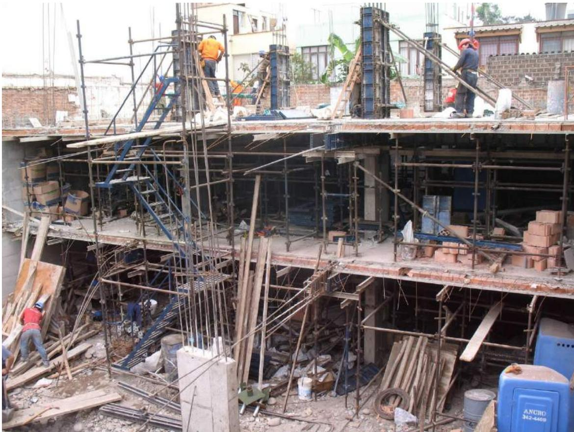
En ésta parte de la Obra , nos encontramos encofrando las columnas C-1 y C-2 del 1er piso, dicho encofrado se realizaba al día siguiente del vaceado de la losa. Pero ya no podíamos seguir subiendo, era hora de continuar con la excavación de la parte delantera, que se quedó postergada.
