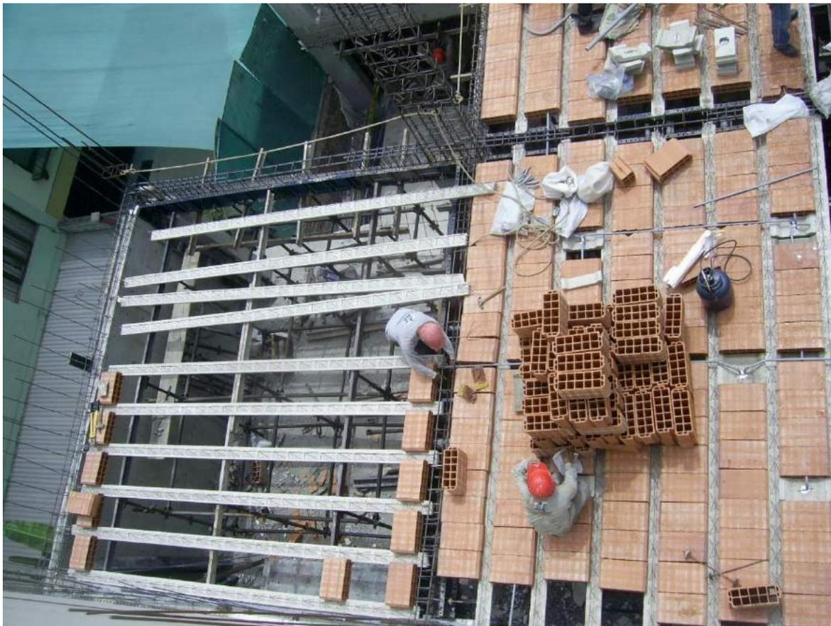
Vista aérea del armado del 2do techo , día 4to , al día siguiente estaba programado el vaciado del techo , nótese las baterías de SSHH, éstos eran armados , días previos en otra área y luego
