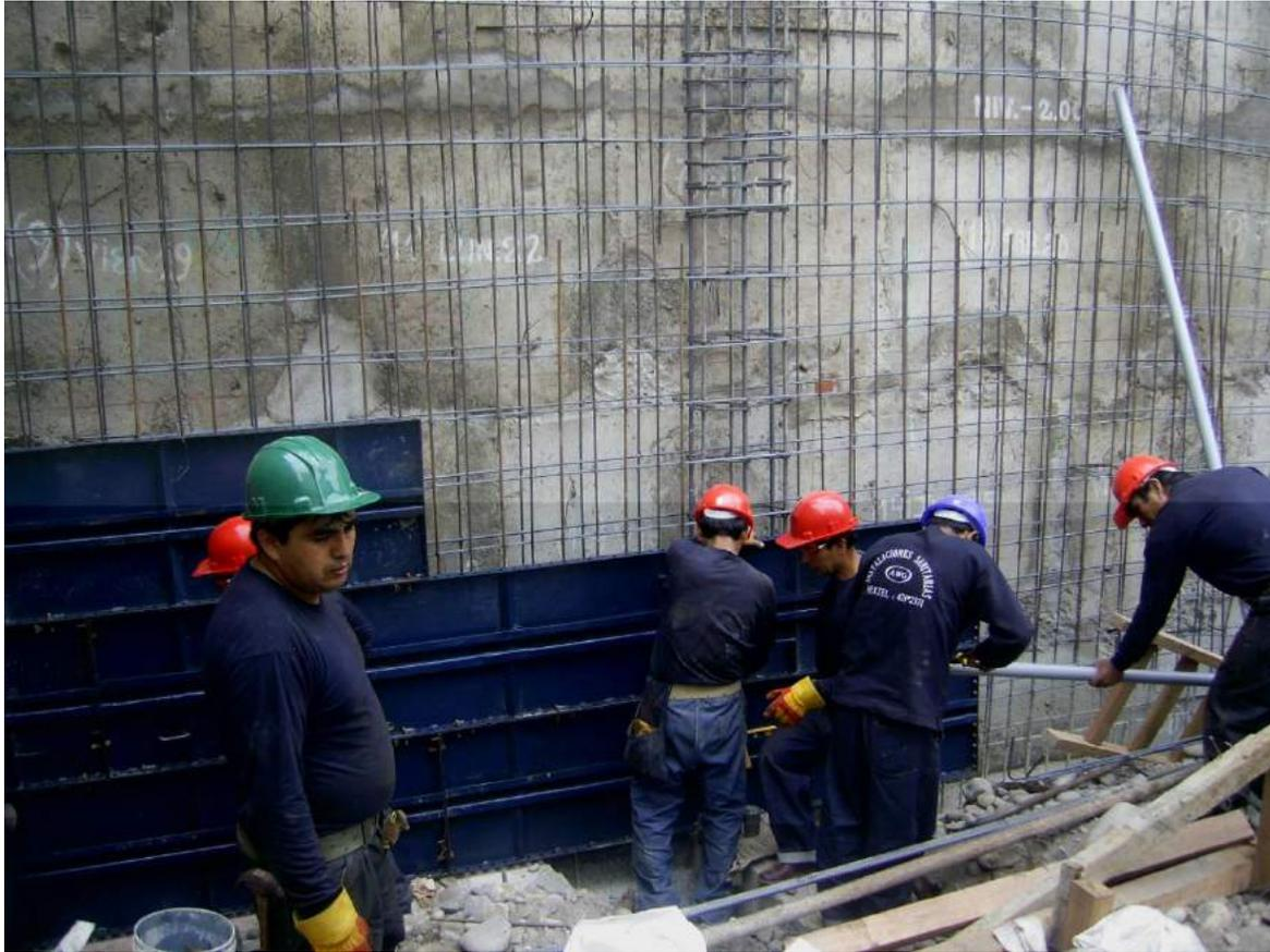
Como se aprecia en la foto se utilizaron en todo el proceso de la Obra encofrado metálico, con la finalidad de obtener superficies con mejor acabado , para ello se utilizaron desmoldantes en los paneles a usarse.
