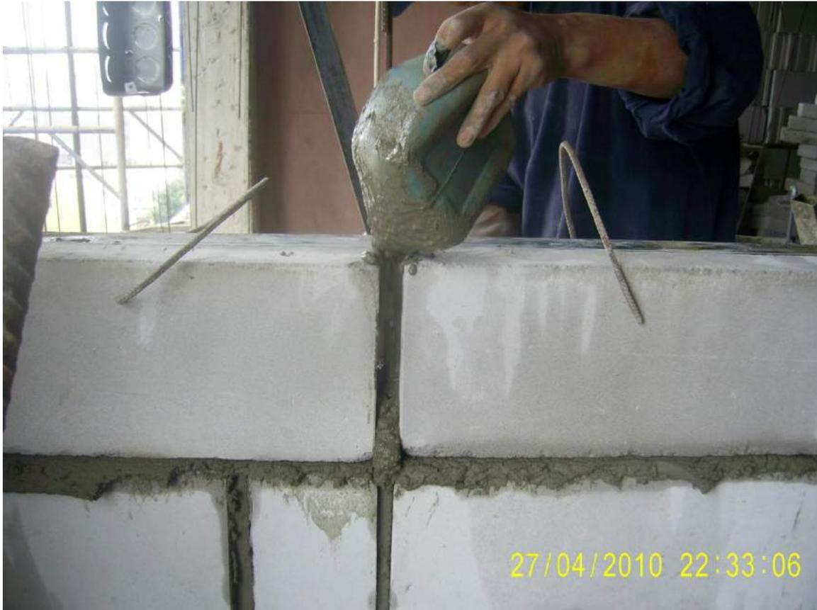
La foto nos muestra el preciso instante que el mortero liquido ingresa por las juntas entre ladrillos para su fijación definitiva, luego de los cuales con una regla se va alineando las bloquetas levantadas.
