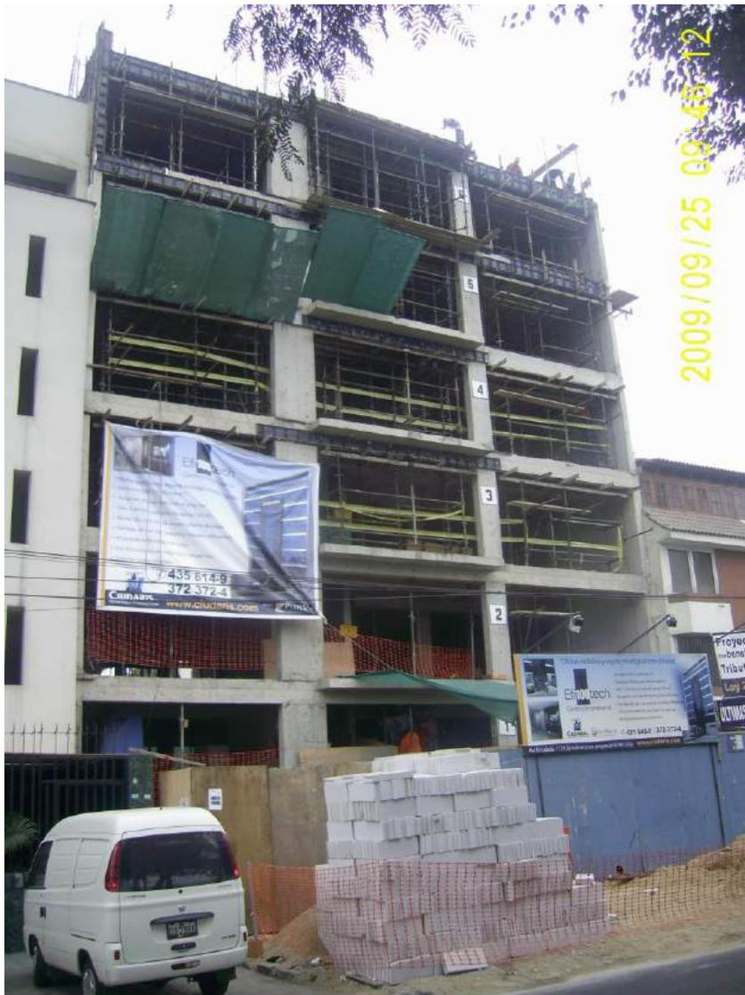
La foto nos presenta al Edificio con la losa del 6to piso terminada . Nótese que ya se estaba empezando con la partida de albañilería
