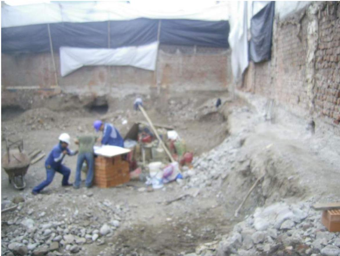
El personal Obrero a la par, se encargó de ir excavando el terreno e los Ejes D y eje 6 ,de manera alternada , con las medidas de seguridad que el caso amériita para el inicio de la construcción de las calzaduras.
