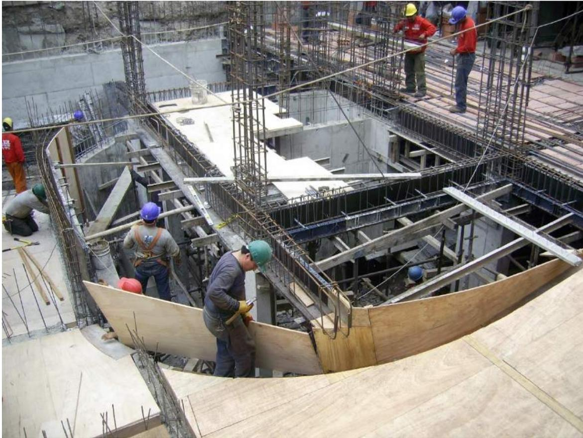
Como lo dijimos antes , una vez terminado de vacear las paredes laterales de las dos cisternas y del cuarto de máquinas , se procedió a encofrar la rampa de acceso a estos dos niveles , como se aprecia se utilizó paneles de triplay de 10 mm ,por ser más versátiles.
