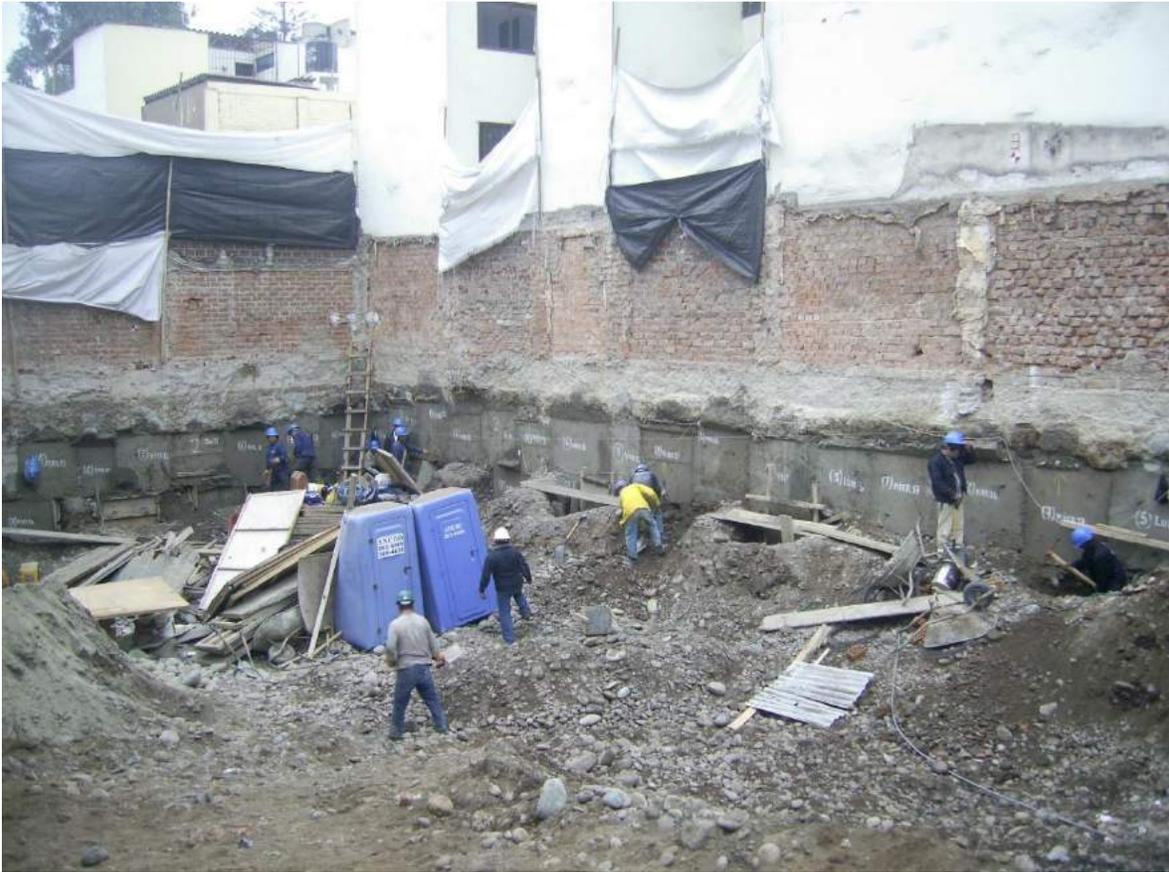
Una vez terminada de calzar la estructura vecina , se procedía a seguir excavando con la maquinaria pesada hasta conseguir bajar hasta la cota -5.80 mts y hasta la cota – 6.30 en la parte de las cisternas ( zona delantera ).
