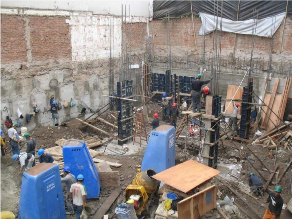
Los paneles de encofrado se habían contratado para 12 ml de muro y para dos columnas C-1 y C-2 . Los vaceados eran todos los días. En algunos casos se tuvo que completar algunos costados de columnas con madera. Los vaceados estaban programados para las 2.00 pm, esto quiere decir que todos los elementos verticales tenían que estar terminados para esa hora o la gran mayoría de ellos .
