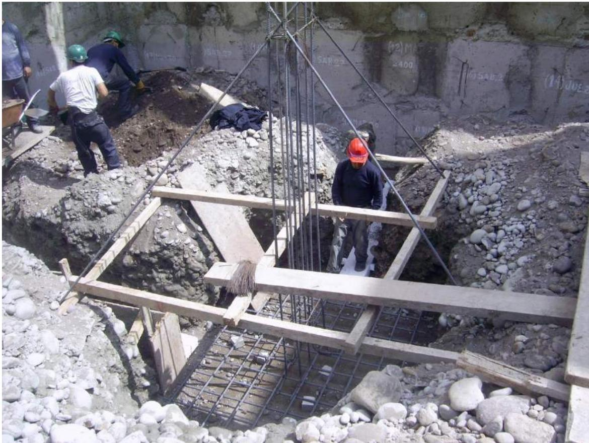
La zapata de la foto perteneciente a la columna C-1 tuvo como malla  $\phi=3/4''$  en ambos sentidos, se utilizó dados de concreto para asegurar el recubrimiento solicitado en proyecto. y estuvo confinado por la pared de concreto.
