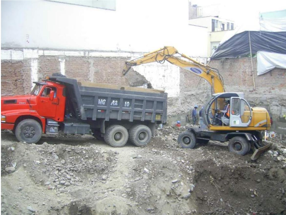
Paralelamente se iban excavando las calzaduras de los ejes A de la parte posterior hacia adelante.
