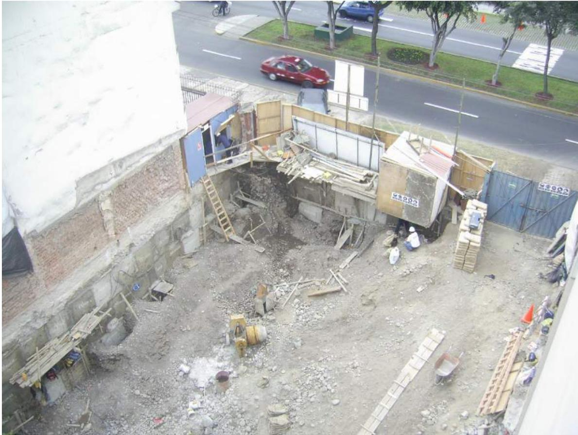
Como ya lo dijimos antes , se ha terminado de calzar una parte del eje 1. veáse el almacén en volado y la rampa generada por la excavación masiva . En esta parte de la obra se está coordinando la llegada de la maquinaria pesada , para la culminación del movimiento de tierra.
