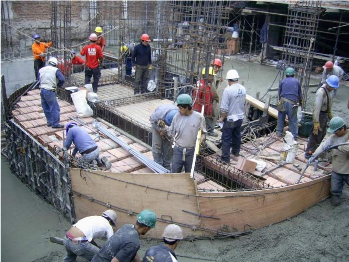
La foto nos muestra la secuencia de vaciado , terminamos el llenado de la parte inconclusa del sótano y procedemos a llenado de la rampa y acceso vehicular .
